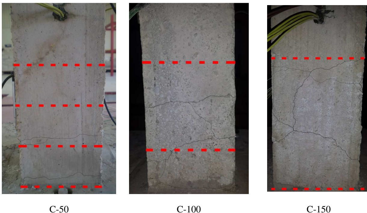
Slika 3.65 Izgled stupova pri dnu nakon završenog testiranja
