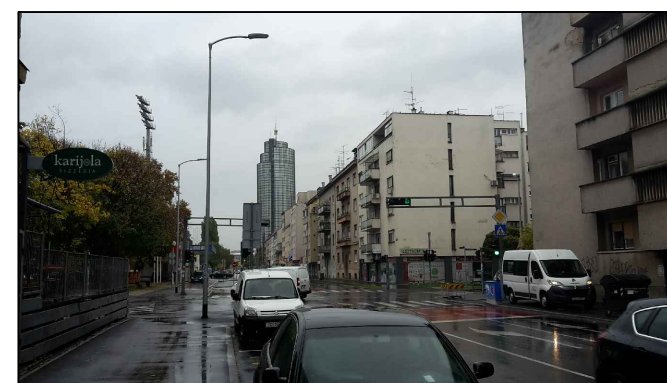
Kranjčevićeva ulica, P+4
