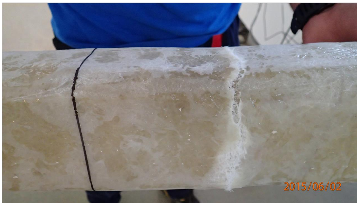
Fotografija 2.15 Prikaz pukotina
