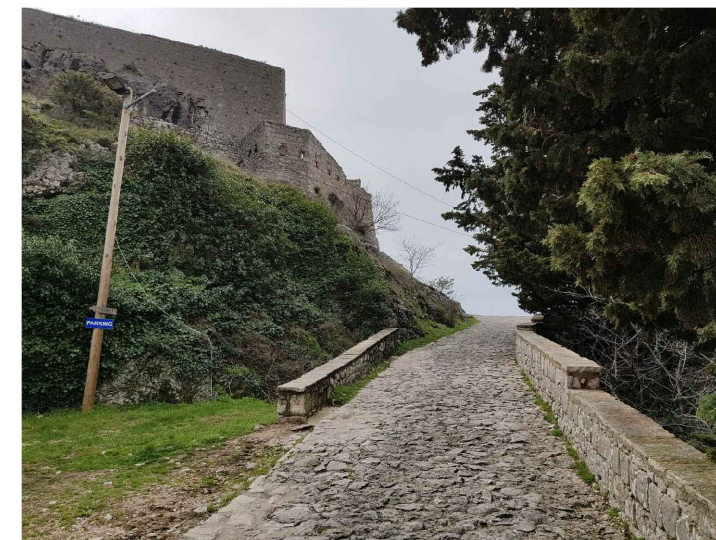
slika br. 74 - fotografija postojećeg stanja
