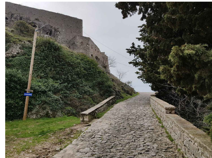
slika br. 74 - fotografija postojećeg stanja
