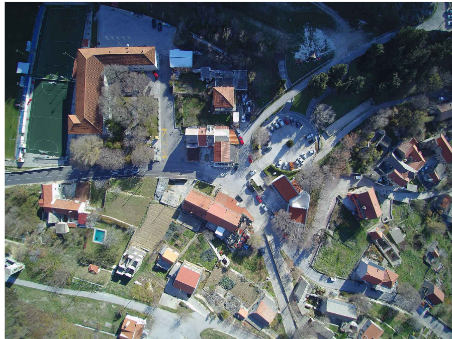
slika br. 68 - fotografija postojećeg stanja
