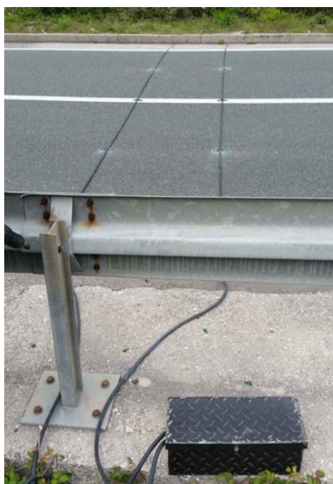
Slika 3.2. Način postavljanja brojila MetroCount 5600
