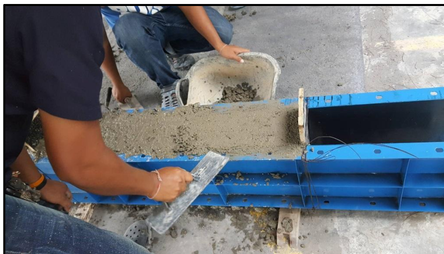
Slika 66. Zaglađivanje površine betona
