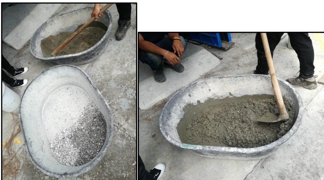
Slike 52. Priprema mješavine za beton
