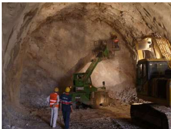
Slika 2. Radovi na iskopu tunela [2]
