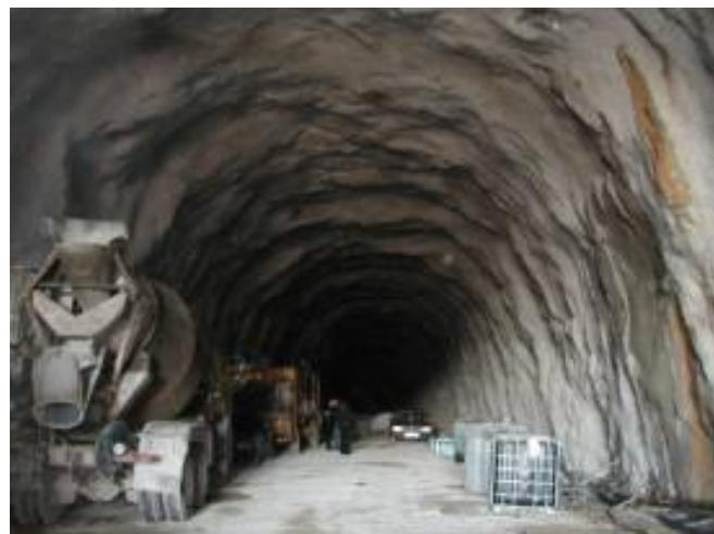
*Slika 5. Primarna podgrada tunela [5]*
