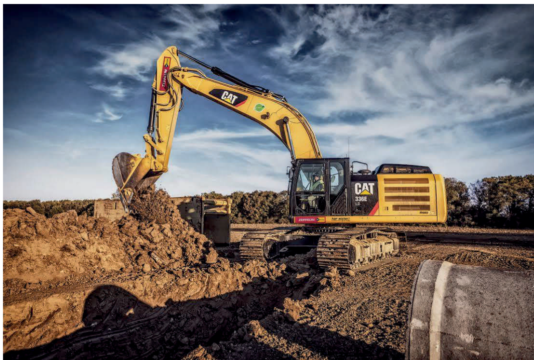
Slika 13. Iskop materijala jaružalom CAT 336 EL [13]
