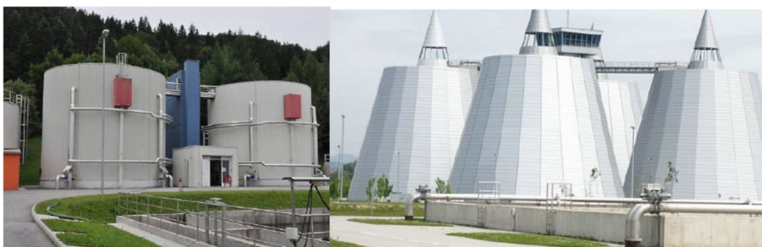
Slika 6.7. Složeni oblik digestora
