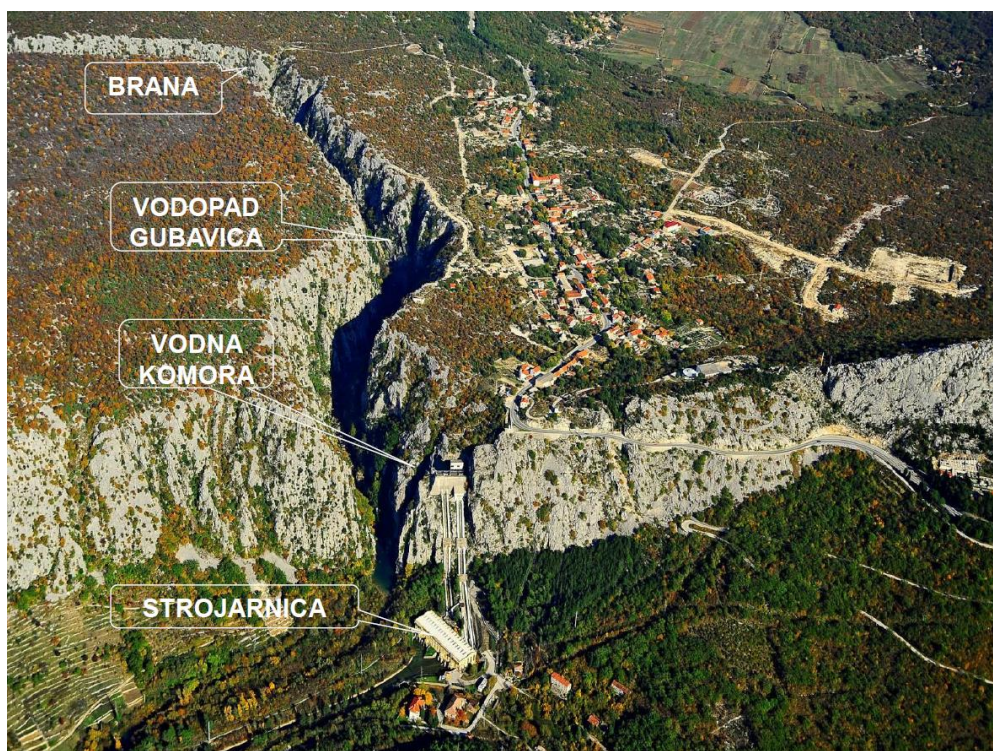
Slika 8. Sastavni dijelovi HE Kraljevac
