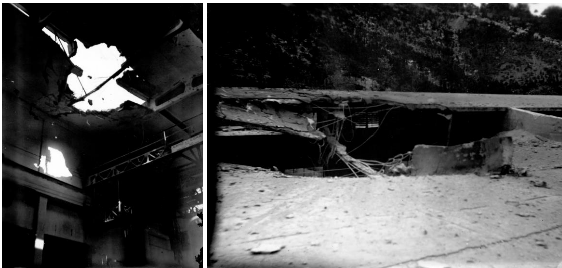
Slika 21. Bombardiranje strojarnice (1943. g.)
