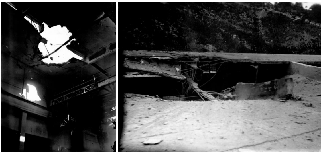
Slika 21. Bombardiranje strojarnice (1943. g.)
