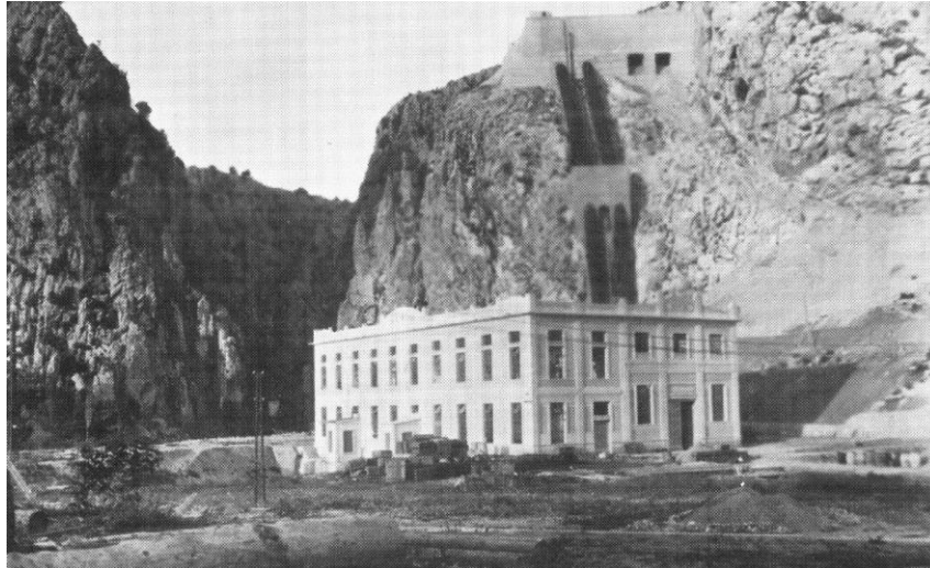
Slika 17. Završeni radovi prve faze izgradnje
