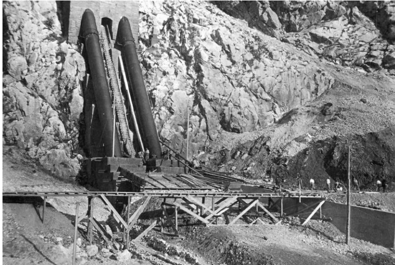
Slika 16. Radovi na izgradnji prva dva cjevovoda
