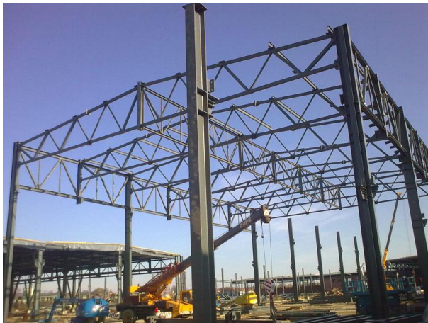
Slika 1.1.3. Montažna izvedba čelične hale
