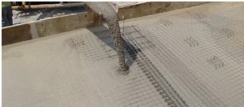
Slika 2.3. Samozbijajući beton tokom ugradnje [9]
