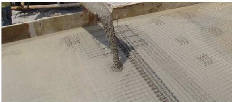
Slika 2.3. Samozbijajući beton tokom ugradnje [9]
