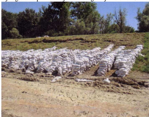
Slika 8.22 Klizište na nizvodnoj (zračnoj) strani nasipa uslijed djelovanja procjeđivanja kroz nasip pri ekstremno visokom vodostaju (Roje-Bonacci, 2015.)
