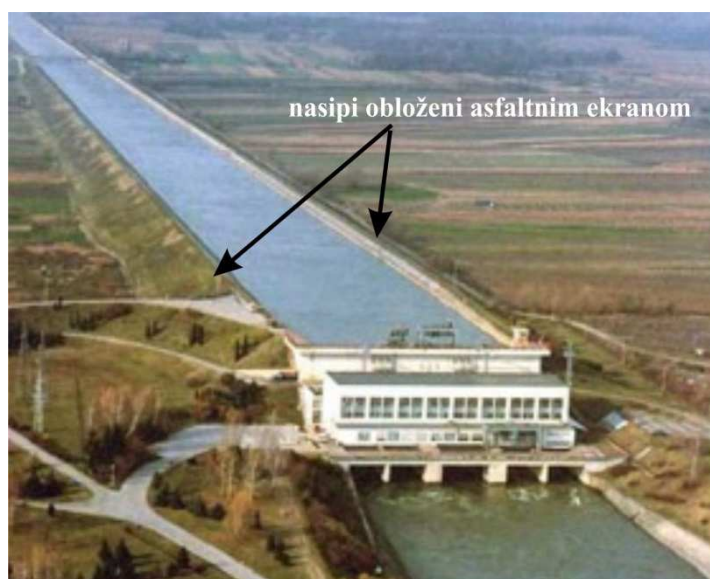
Slika 9.8 Dovodni kanal HE Varaždin, obložen asfaltnim ekranom
