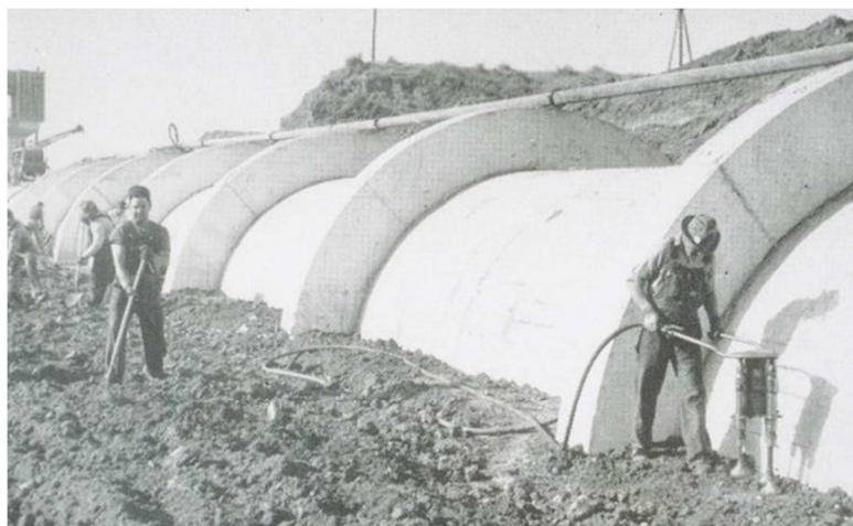
Slika 8.33 Ugradnja cijevi i spojnica (FEMA 484, 2005.)
