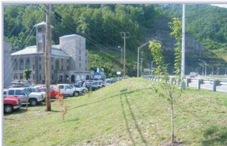
Slika 6.8 Hidrotehnički nasip koji je ujedno i trup autoceste
