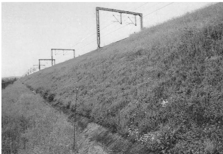
Slika 9.25 Gabionska zaštita kao podloga za travu (Roje-Bonacci, 2012.)
