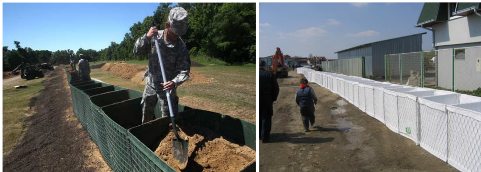
Slika 8.7 Obrana od poplave, svibanj 2011. Luisiana, USA, i gabioni u pripremi (L. Tadić)
