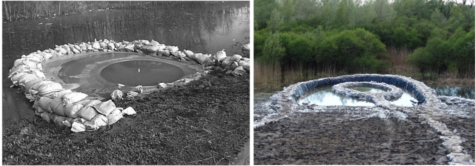
Slika 8.44 Povećanje razine na izlazu, pomoću zečjeg nasipa lijevo Fell, (2015.), desno L. Tadić, Dunav, travanj 2006.
