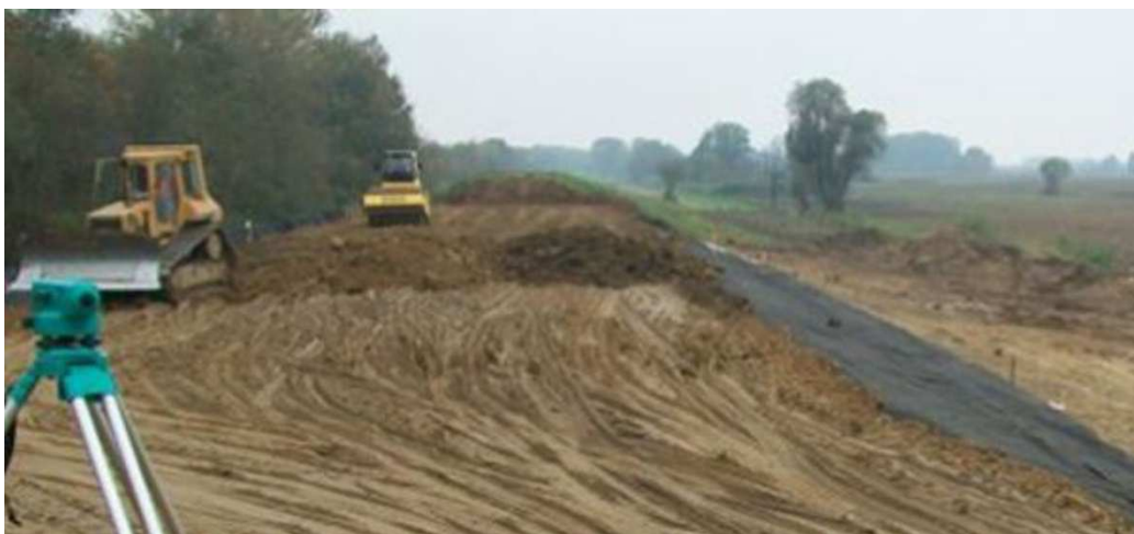
Slika 3.18 Kontrolirana ugradnja tla u nasipe sa zbijanjem (Istočna Slavonija)
