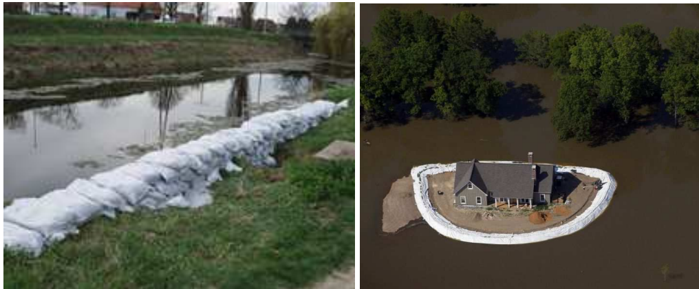
Slika 8.2 Zečji nasip, Karašica 2006. ( L. Tadić.) i uz samostojeću kuću (faslany, 2011.)
