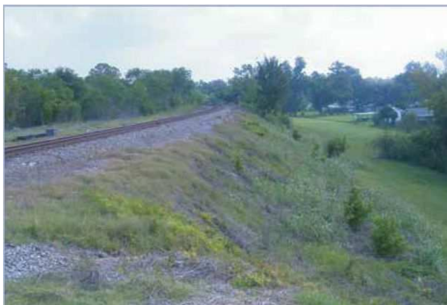
Slika 6.9 Željeznički nasip ujedno nasip za obranu od poplave
