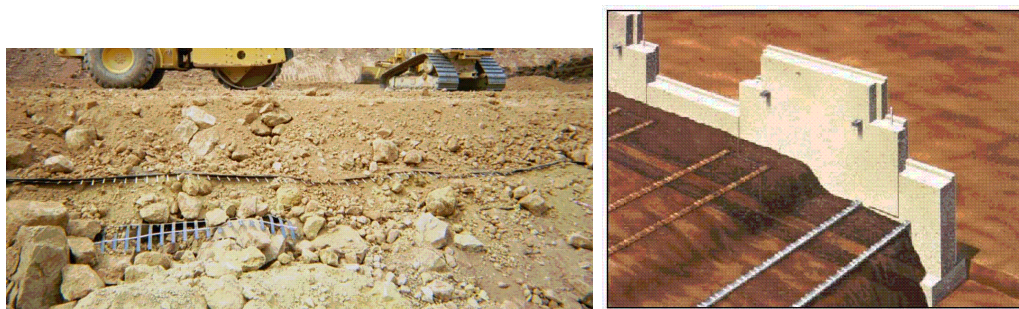
Slika 6.31 Nasip armiranim geomrežom, bez lica, lijevo i zategama s licem, desno
