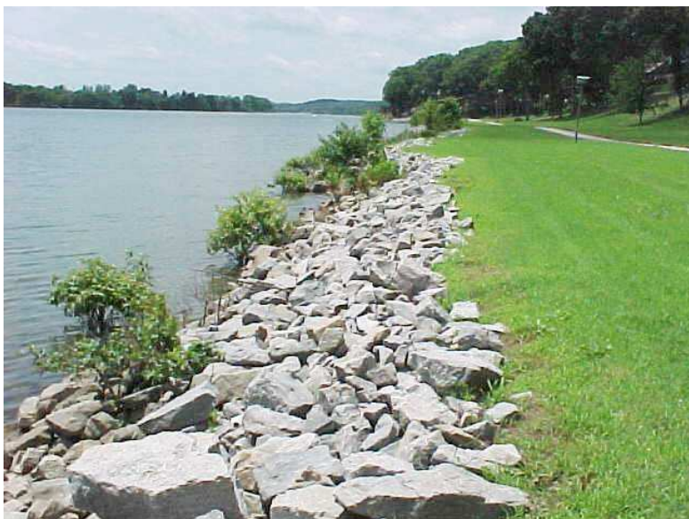
Slika 9.27 Rip-rap obloga uzvodne strane nasipa
