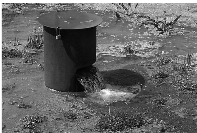
Slika 8.43 Bunar za poravnanje tlakova
