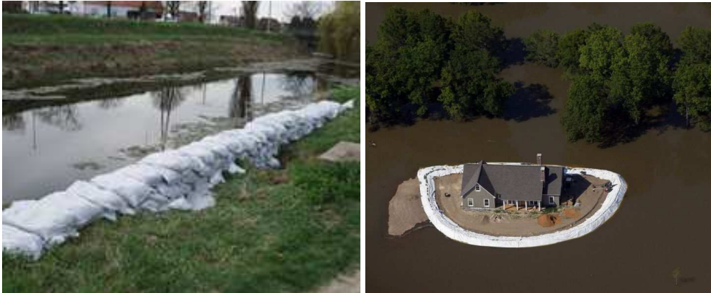
Slika 8.2 Zečji nasip, Karašica 2006. ( L. Tadić.) i uz samostojeću kuću (faslanyc, 2011.)
