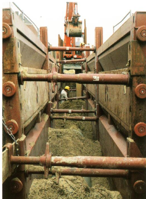
Slika 8.20 Sustav oplata s pločama i vodilicama
