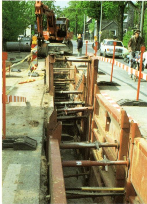
Slika 8.19 Sustav oplata za iskop kanala s pločama
