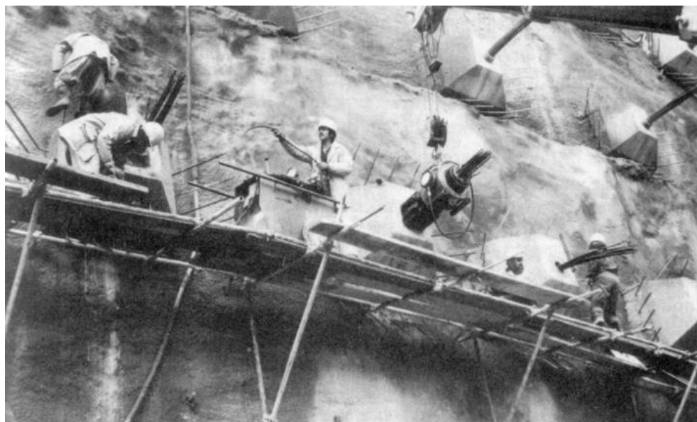
Slika 7.26 Sidra s blokovima i prskanim betonom (Hanna, 1985.)
