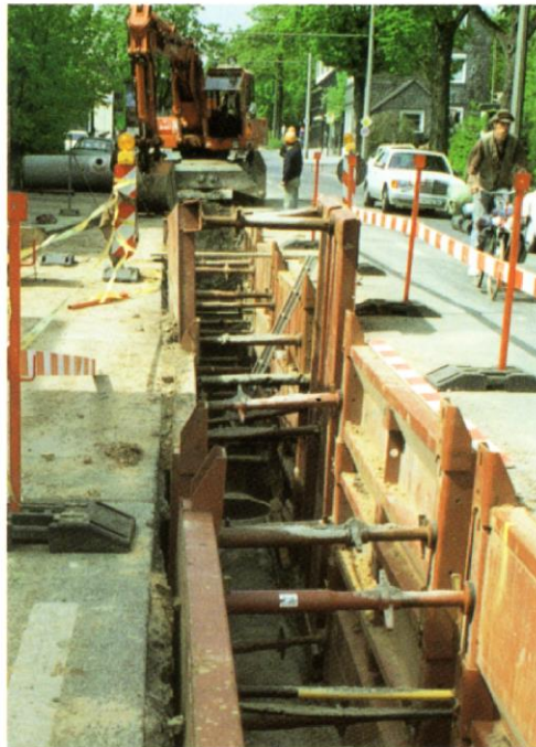
Slika 8.19 Sustav oplata za iskop kanala s pločama
