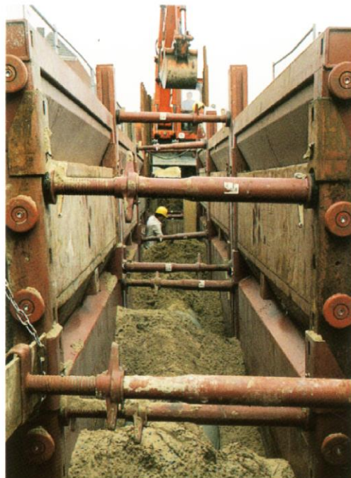
Slika 8.20 Sustav oplata s pločama i vodilicama
