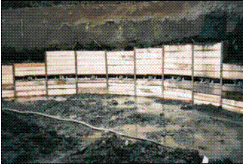
Slika 8.25 Berlinsko zide u dnu građevne jame
