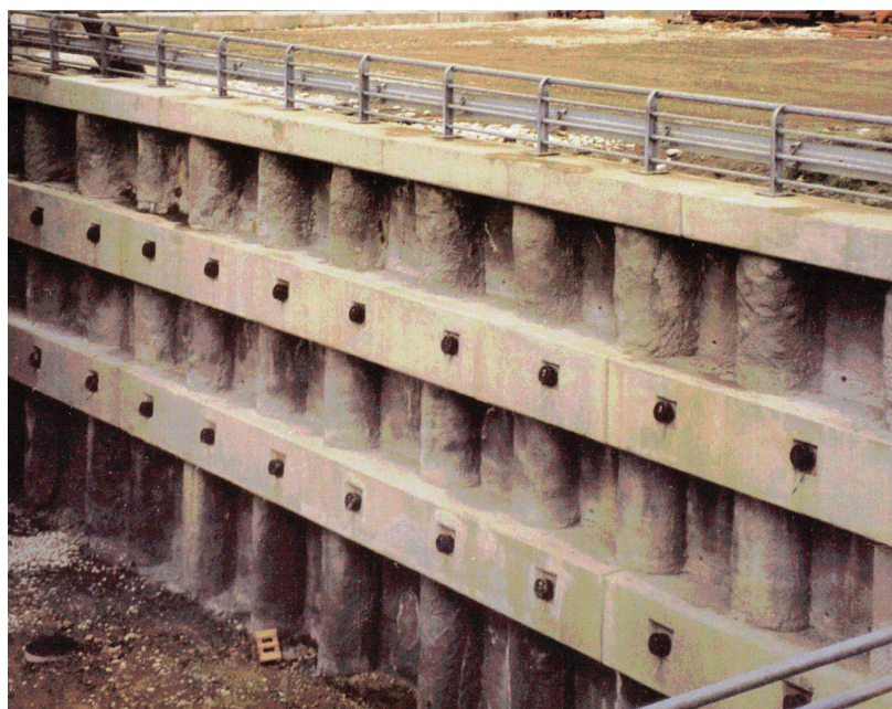
Slika 5.47 Otkopana stijanka izvedena metodom pilot do pilota s gredama i sidrima
