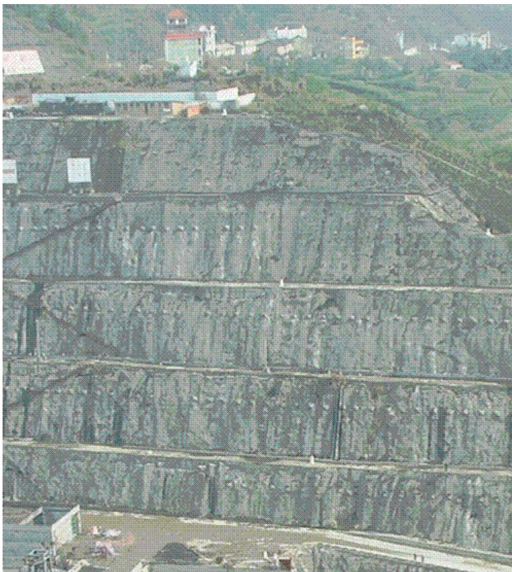
Slika 7.30 Usidreni pokos iskopa za brodsku prevodnicu na brani Tri klanca u Kini, sidra bez površinske zaštite pokosa
