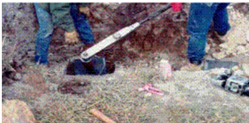
Slika 7.10 Prednaprežanje sidra moment ključem
