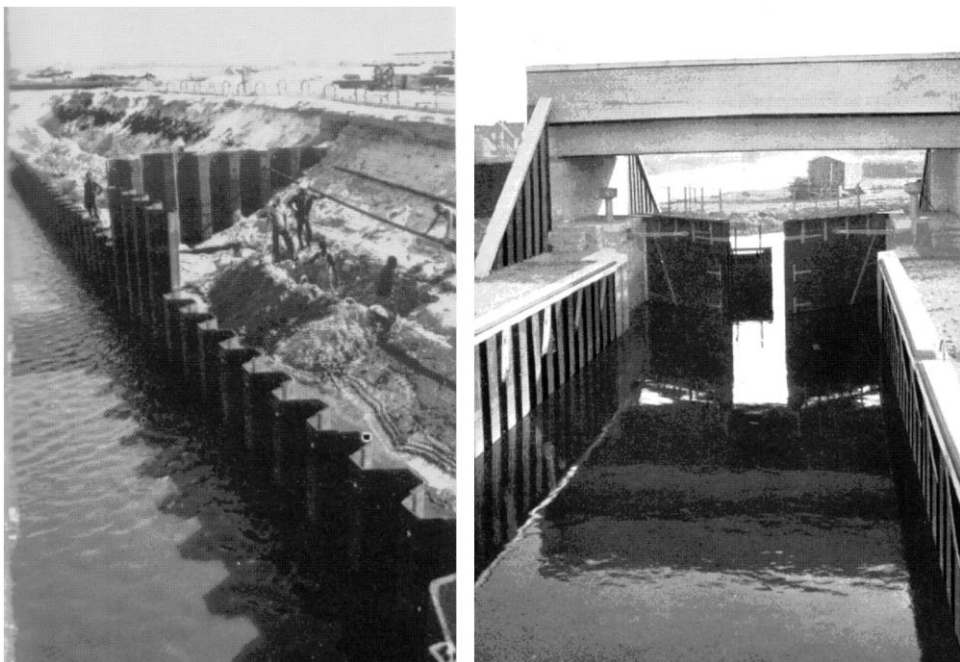
Slika 5.26 Zagatne stijenke od čeličnih platica
