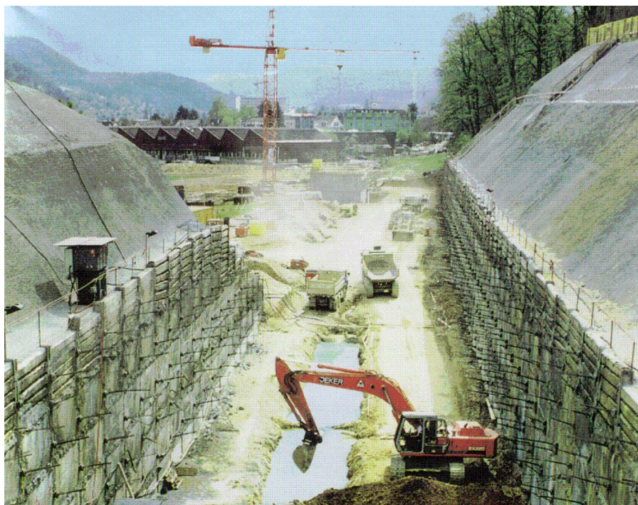
Slika 7.28 Složena sidrena građevina (BBR-CONEX, 1996.-1998.)
