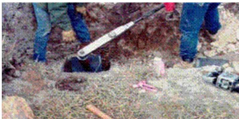
Slika 7.10 Prednaprežanje sidra moment ključem
