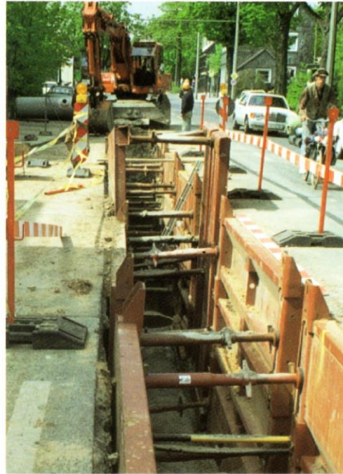
Slika 8.19 Sustav oplata za iskop kanala s pločama
