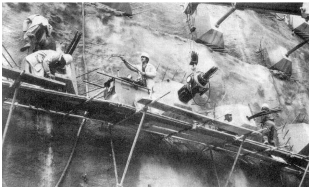
Slika 7.26 Sidra s blokovima i prskanim betonom (Hanna, 1985.)
