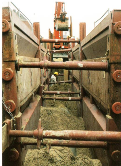
Slika 8.20 Sustav oplata s pločama i vodilicama
