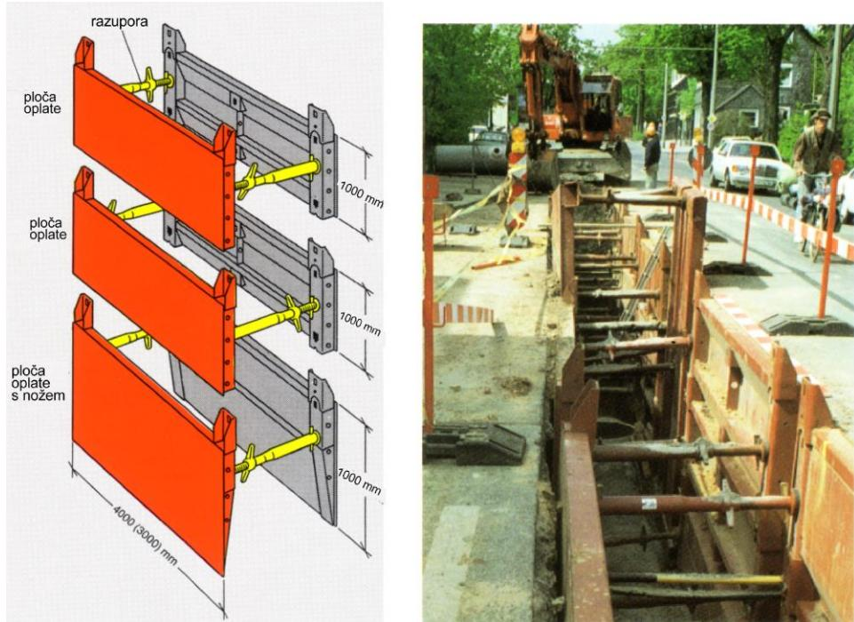
Slika 8.19 Sustav oplata za iskop kanala s pločama
