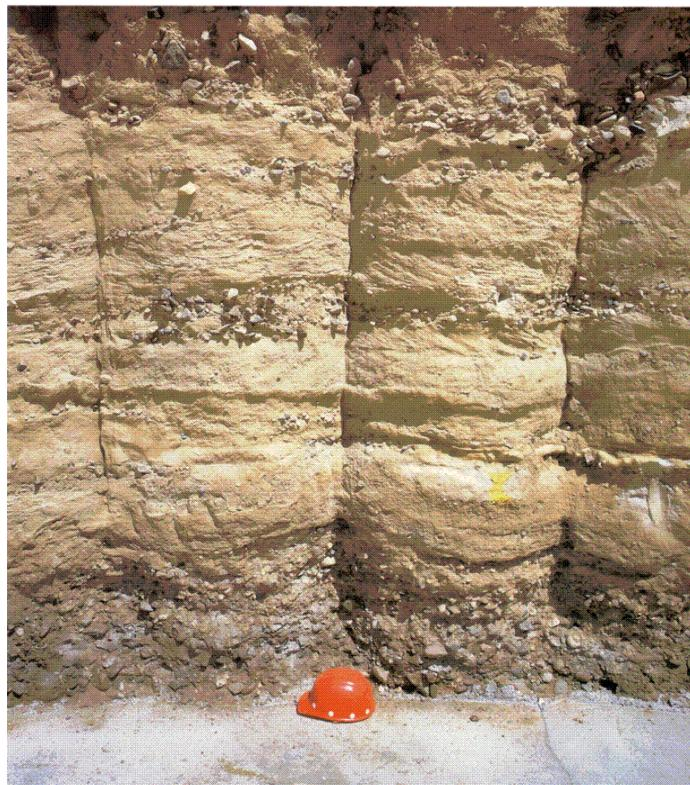
Slika 5.50 Otkopani niz stupnjaka izveden mlaznim injektiranjem
