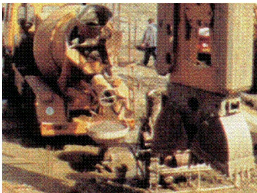
Slika 5.44 Betoniranje kontraktor postupkom i otvorena grabilica (Zakladani staveb, 1999.)
