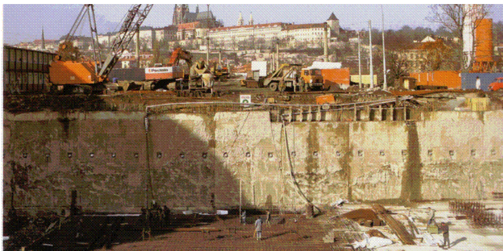
Slika 8.64 Građevna jama zaštićena usidrenom dijafragmom (Zakladany staveb, 1998.)
