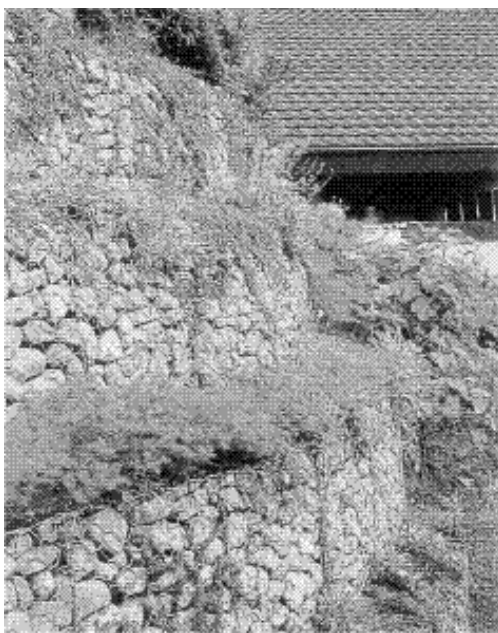
Slika 3.35 Ozelenjeni zid od gabiona (Maccaferri, 1997.)
