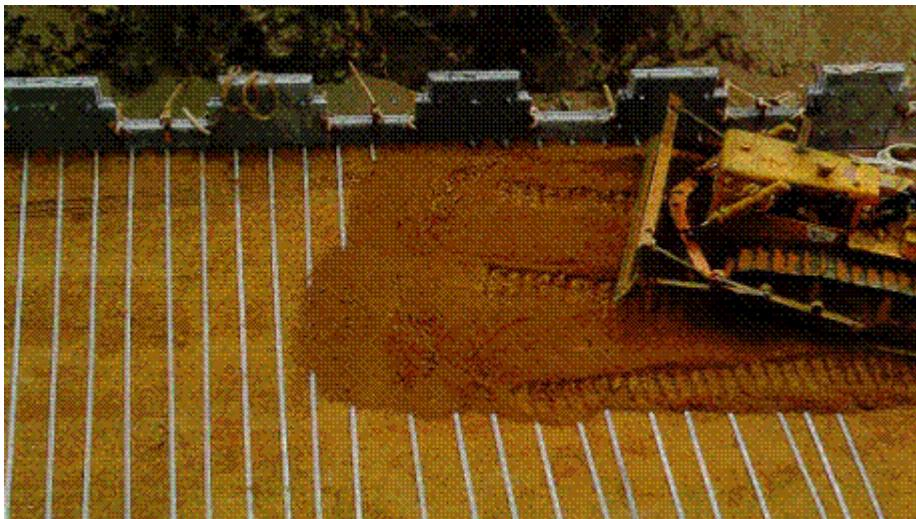
Slika 4.29 Nasipavanje iza lica građevine armirane metalnim trakama
