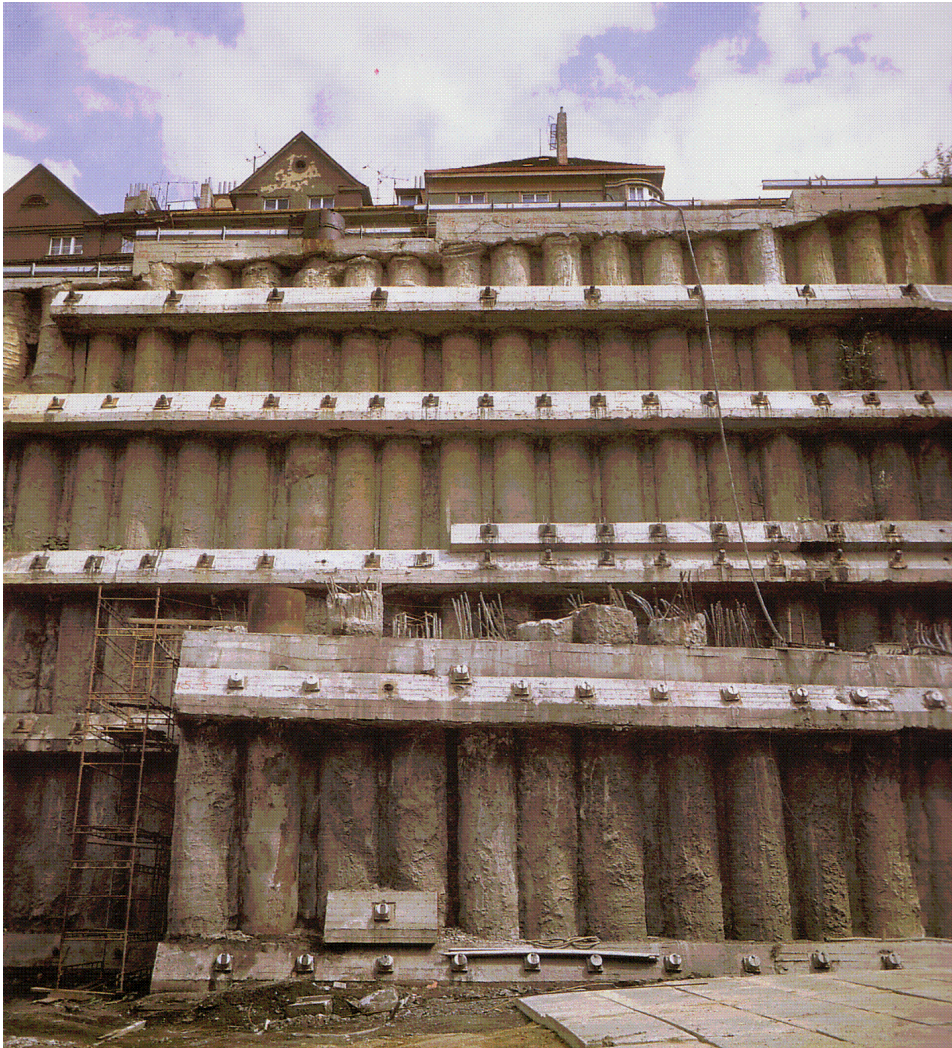
Slika 1.8 Sjeverni portal tunela Strahov (Zakladani Staveb, 1989.)
