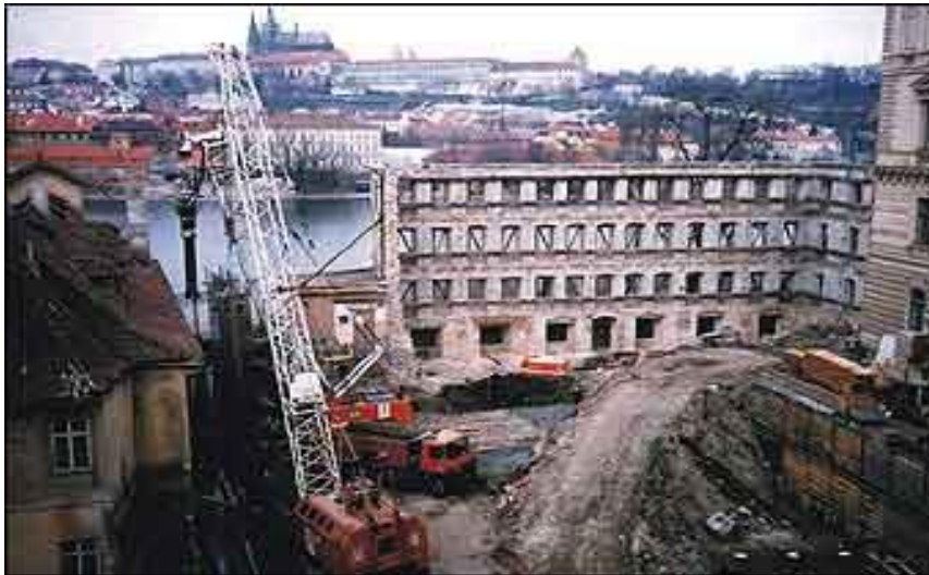
Slika 8.1 Građevna jama u gradskoj jezgri
