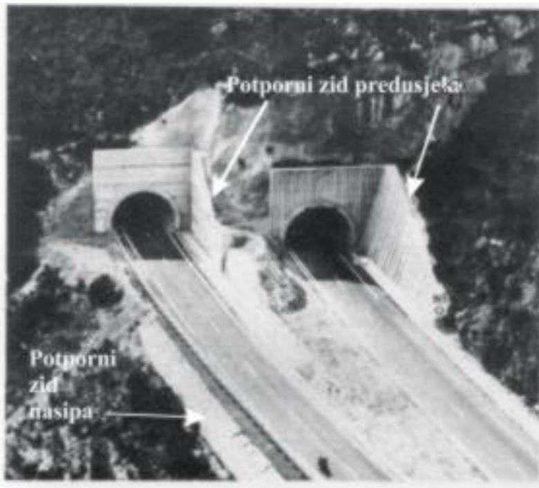
Slika 1.3 Potporni zidovi na autocesti
