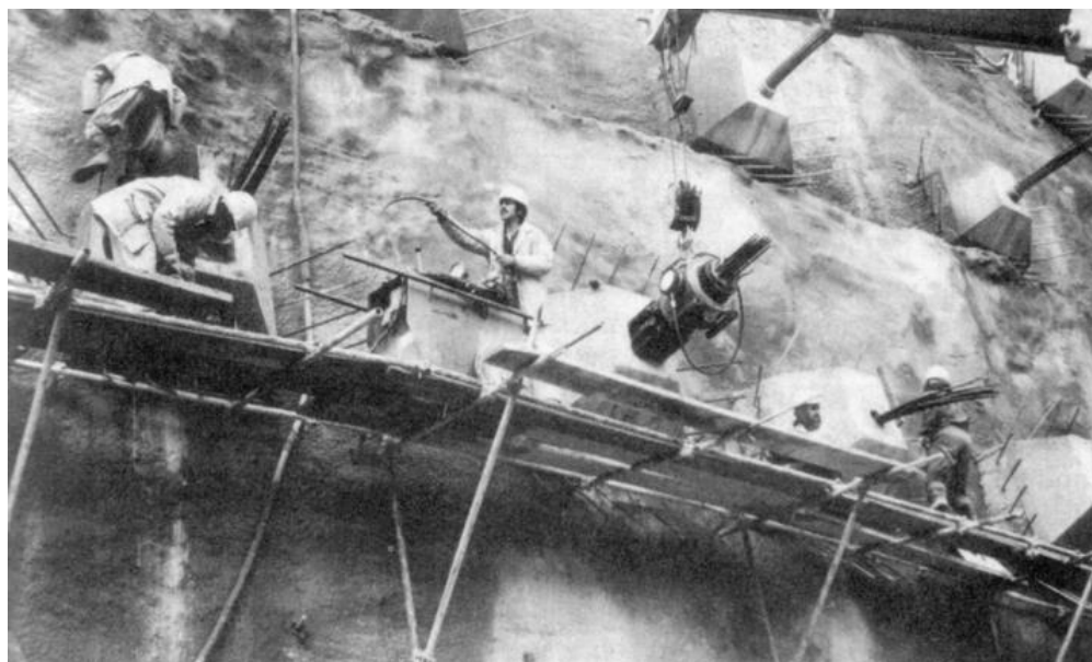
Slika 7.26 Sidra s blokovima i prskanim betonom (Hanna, 1985.)
