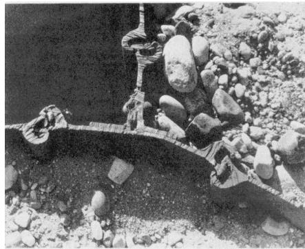
Slika 6.21 Vezna platica za čelijaste zagate od čeličnog žmurja
