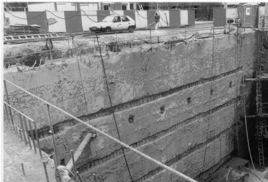
Slika 8.3 Građevna jama zaštićena armirano–betonskom dijafragmom (Jakl, 1999.)
