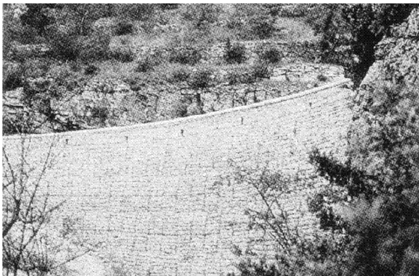
Slika 3.34 Složeni zid od gabiona (Maccaferri, 1997.)
