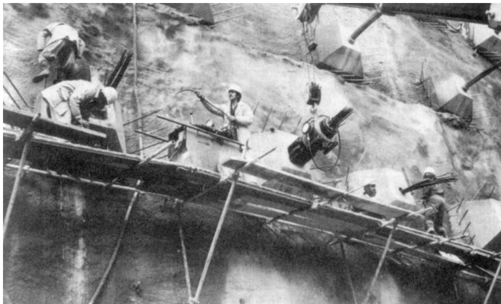
Slika 7.26 Sidra s blokovima i prskanim betonom (Hanna, 1985.)
