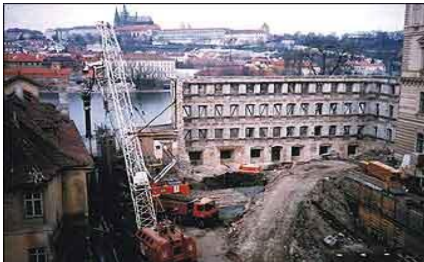
Slika 8.1 Građevna jama u gradskoj jezgri
