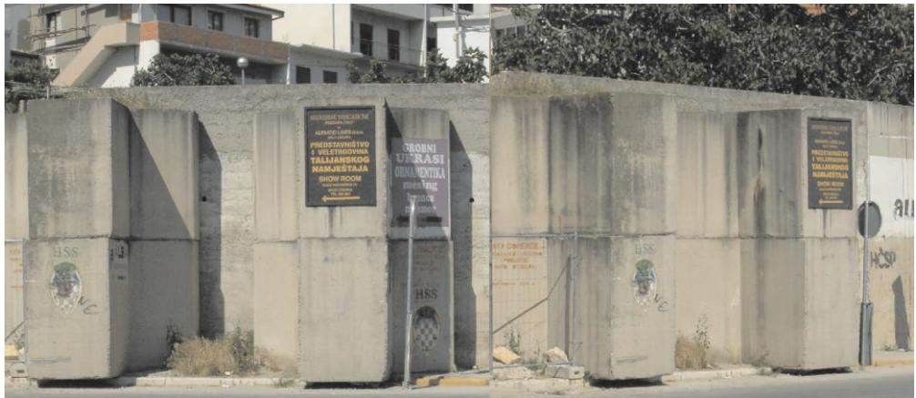
Slika 3.9 Betonski blokovi kao podupore nestabilnom konzolnom zidu
