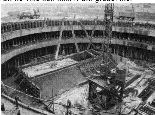
Slika 8.63 Zaštita građevne jame brodske prevodnice uz branu Port-Mort
