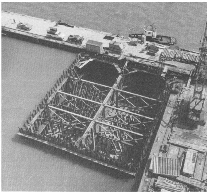
Slika 6.17 Jednoredni zagat od čeličnog žmurja sa sustavom razupora
