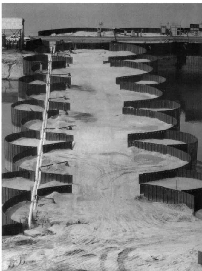
Slika 6.22 Ćelijasti zagat, platice tipa Larsen
