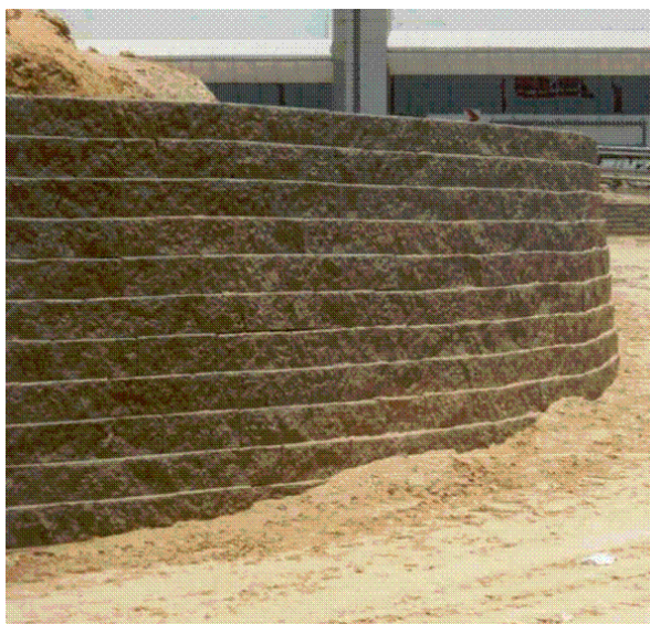
Slika 4.18 Kameno lice zida
