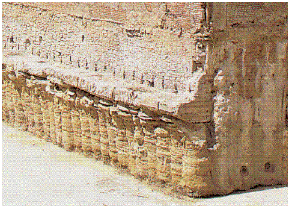
Slika 5.51 Niz mlazno injektiranih stupnjaka ispod temelja zgrade na rubu građevne jame.
