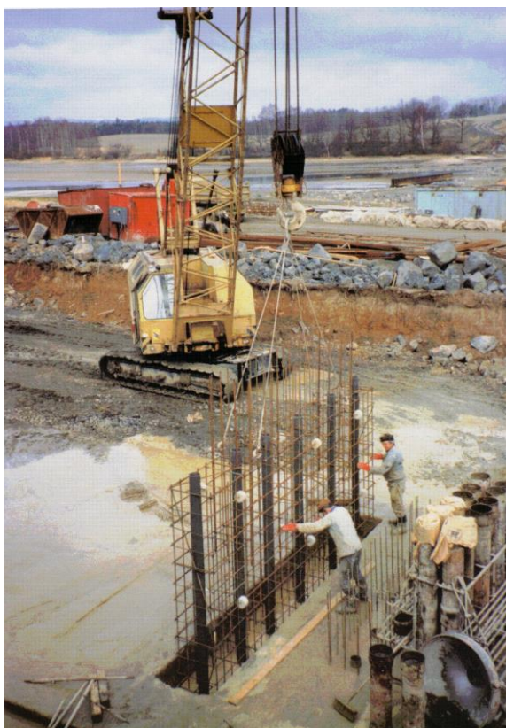
Slika 5.43 Ugradnja armature i cijevi za naknadno injektiranje ispod zagatne stijenke (Zakladani staveb, 1999.)
