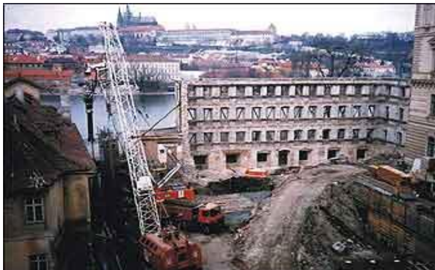
Slika 8.1 Građevna jama u gradskoj jezgri
