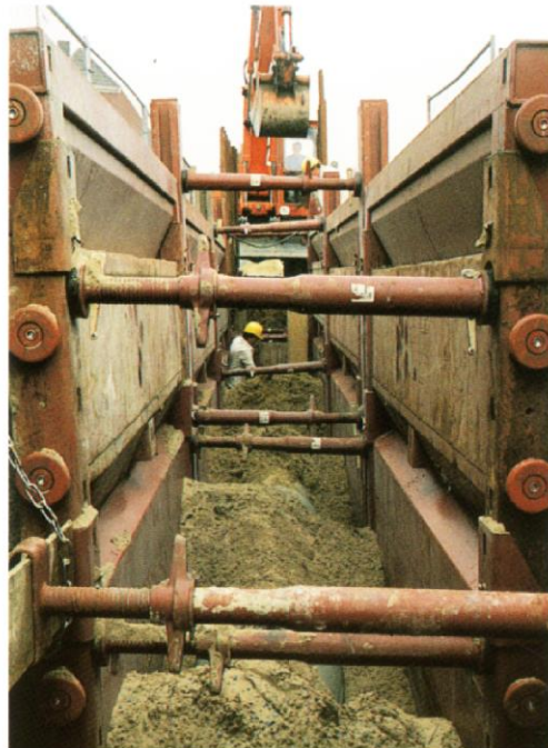
Slika 8.20 Sustav oplata s pločama i vodilicama
