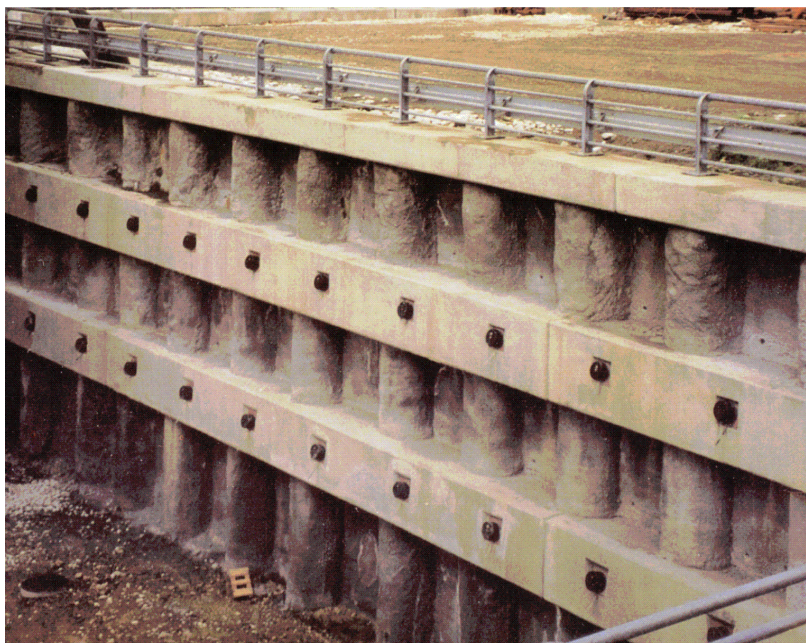
Slika 5.47 Otkopana stijenka izvedena metodom pilot do pilota s gredama i sidrima
