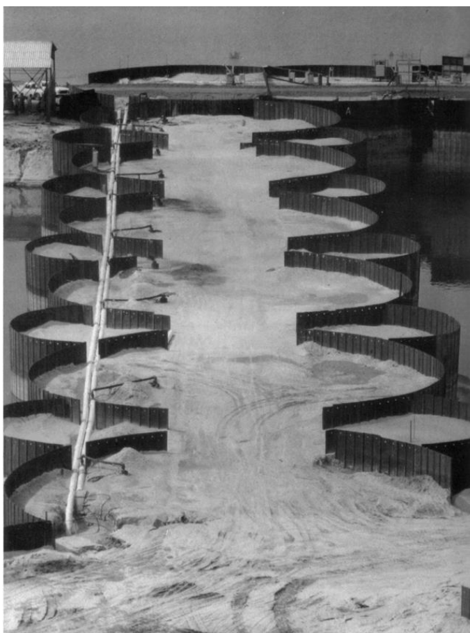
Slika 6.22 Ćelijasti zagat, platice tipa Larsen
