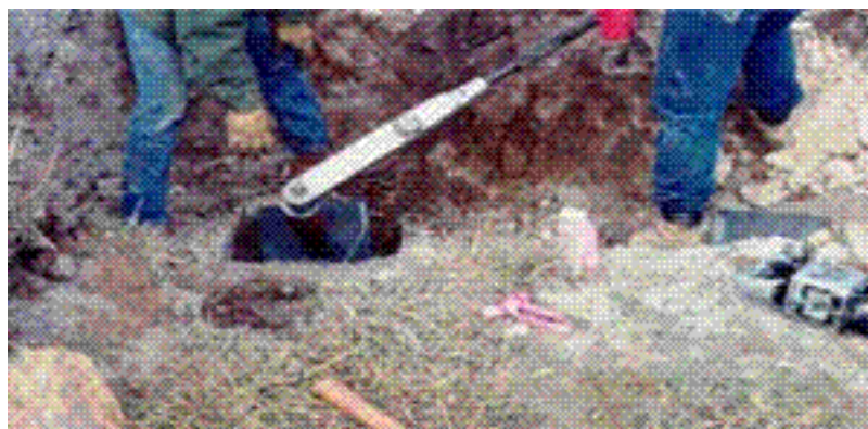
Slika 7.10 Prednaprežanje sidra moment ključem
