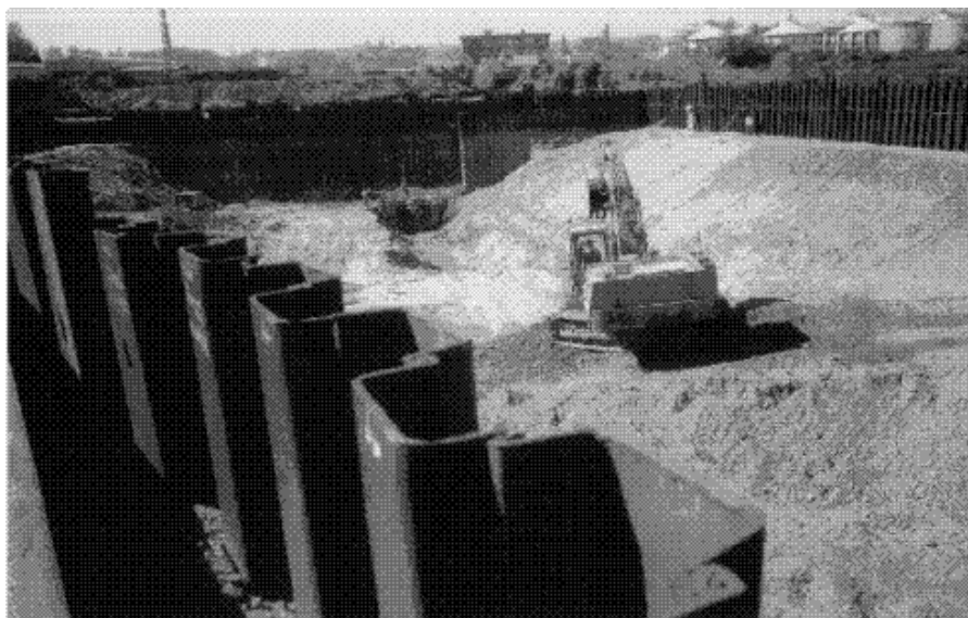
Slika 5.27 Detalj čeličnih platica, čelična zagatna stijenka
