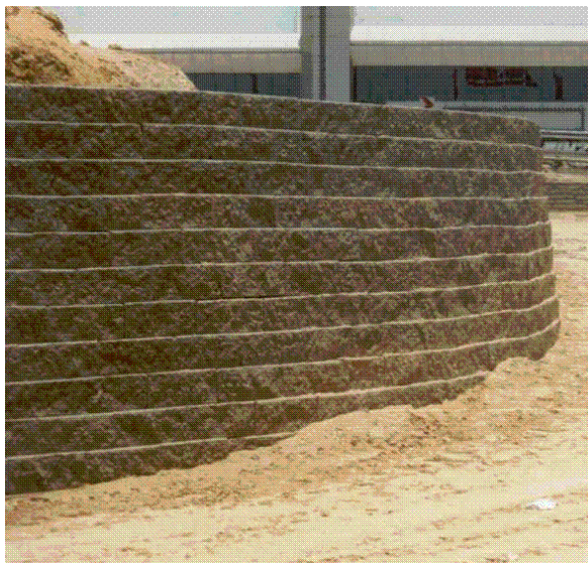
Slika 4.18 Kameno lice zida
