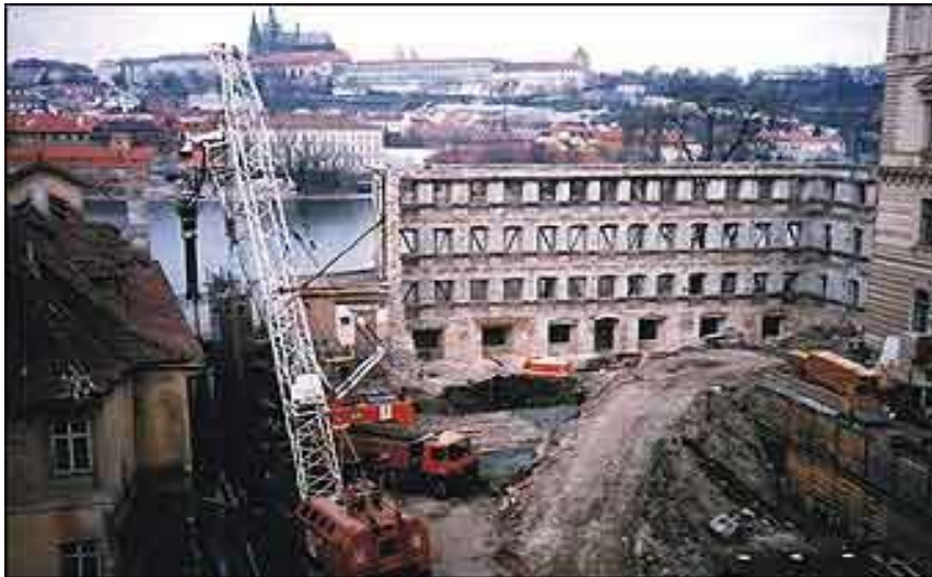
Slika 8.1 Građevna jama u gradskoj jezgri
