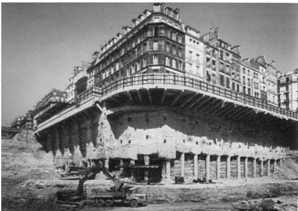
Slika 1.6 Građevna jama stanice podzemne željeznice u Parizu (Hallos, 1979.)
