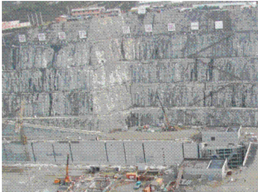
Slika 1.1 Građevna jama sa sidrenim pokosom, brana Tri Klanca
