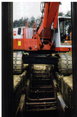
Slika 8.9 Iskop rova između gusjenica
