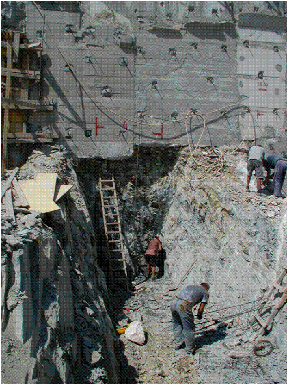
Slika 7.29 Tipična sidrena građevina koja se postepeno spušta, sastoji se od armiranobetonskog platna i niza sidara (snimio Ž. Reljanović)
