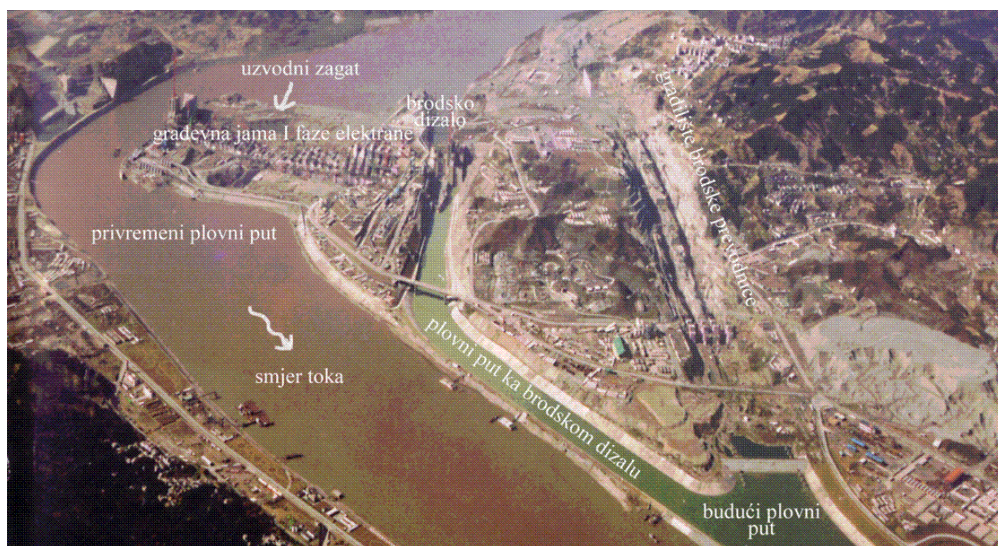
Slika 8.82 Građevne jame za građevine na brani Tri klanca u Kini
