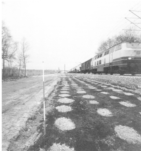
Slika 11.44 Šljunčani stupovi na površini tla
