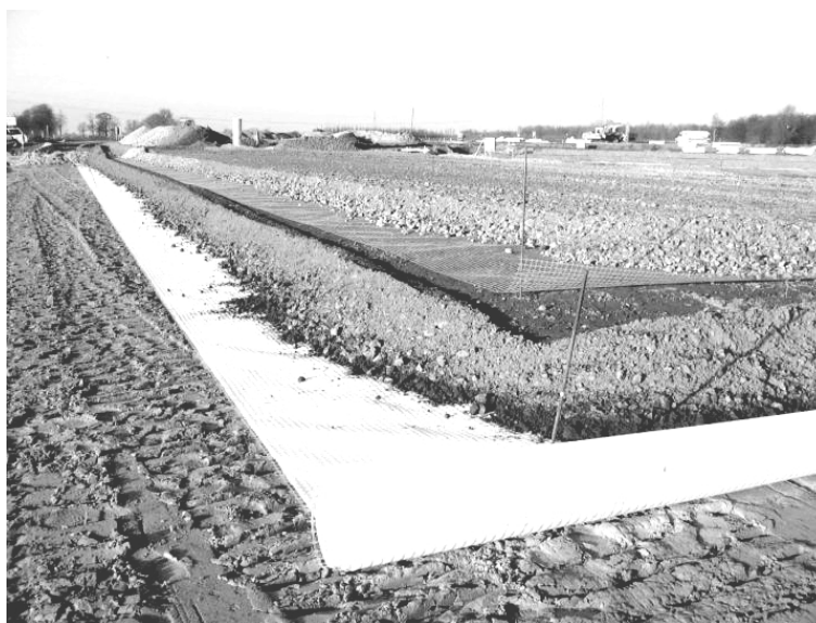
Slika 11.15 Ojačanje posteljice i nasipa geomrežom i geotekstilom
