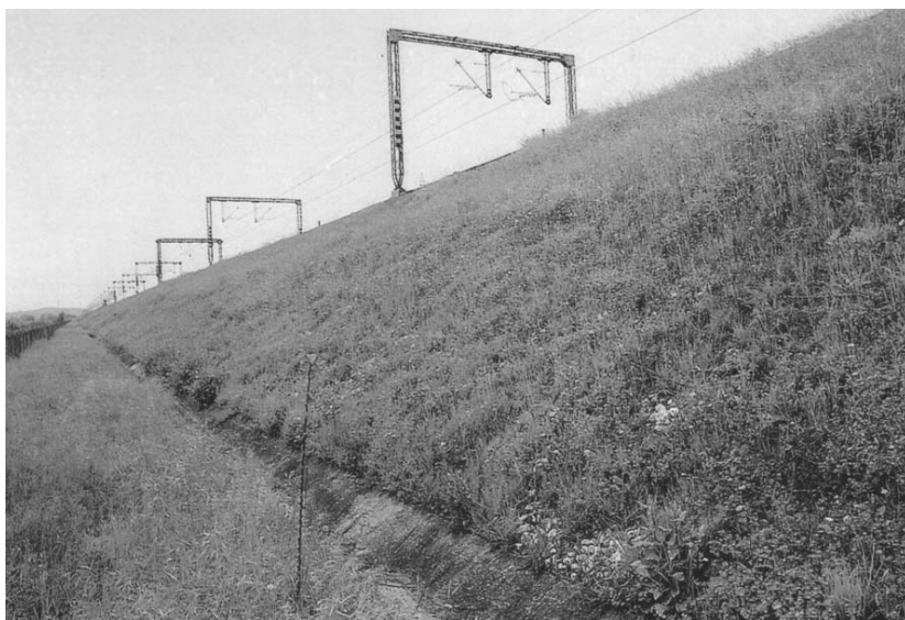
Slika 14.23 Gabionska zaštita kao podloga za travu (Mišćević)
