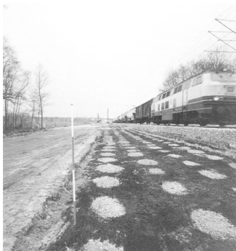
Slika 11.44 Šljunčani stupovi na površini tla
