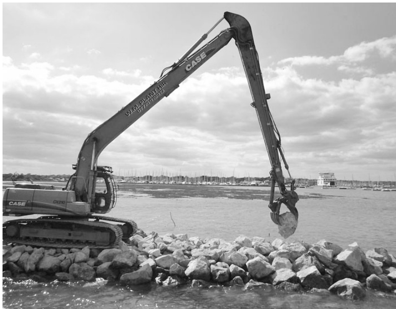
Slika 8.23 Hvatač za polaganje kamena „rip-rap“ na obalu
