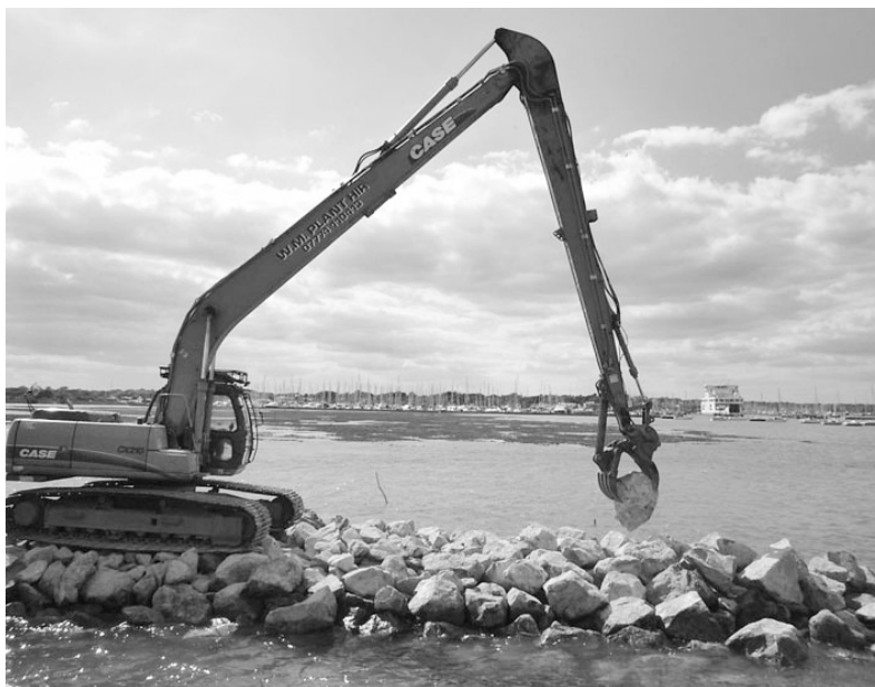
Slika 8.23 Hvatač za polaganje kamena „rip-rap“ na obalu
