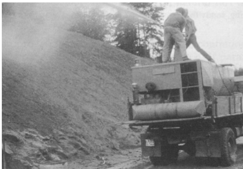
Slika 14.14 Hidrosjetva (Miščević)
