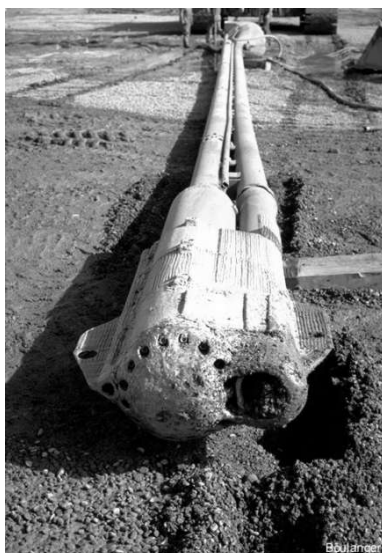
Slika 11.26 Sonda za vibroflotaciju sa cijevi kroz koju se dodaje šljunak u osvojeni prostor u koherentnim tlima, vide se otvori za vodu
