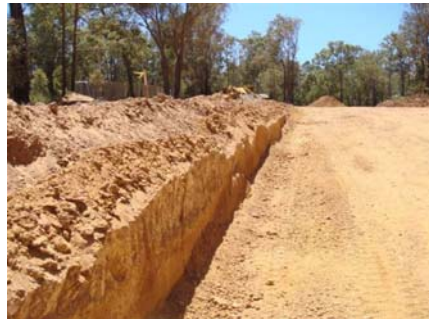
Slika 8.29 Iskop izveden glodalicom sa slike 8.28
