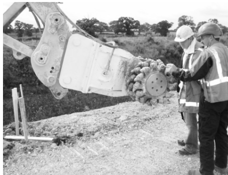
Slika 8.30 Glodač za iskop rova
