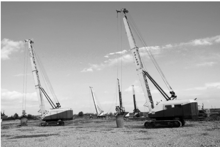
11.22 Polje s nizom strojeva s utegom za dinamičko poboljšanje tla
