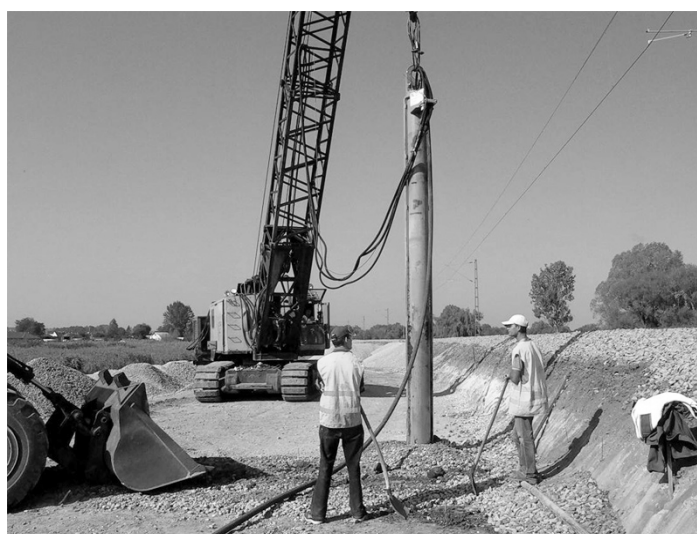
Slika 11.28 Uređaj za vibroflotaciju u radu
