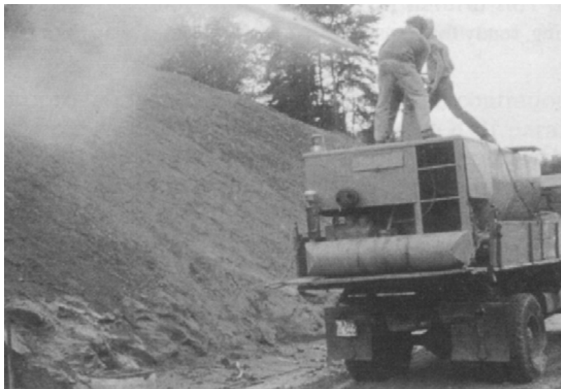
Slika 14.14 Hidrosjetva (Miščević)
