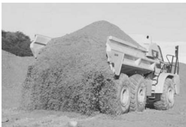
Slika 10.7 Odlaganje s grubim razastiranjem iz dampera
