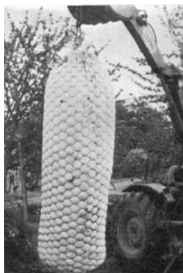
Slika 14.21 Tonjača (sa slike 14.19) od geosintetika, punjena šljunkom
