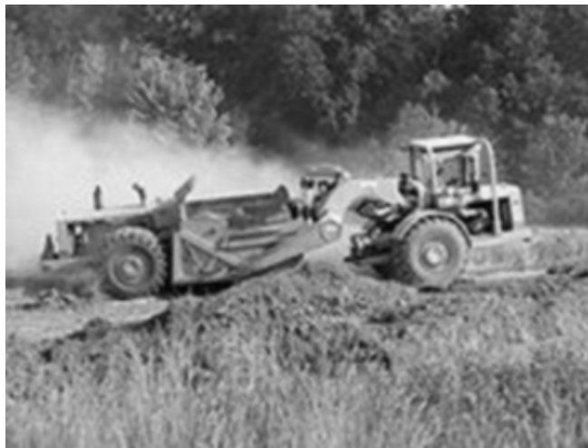
Slika 8.12 Skreper u radu pri iskopu i utovaru
