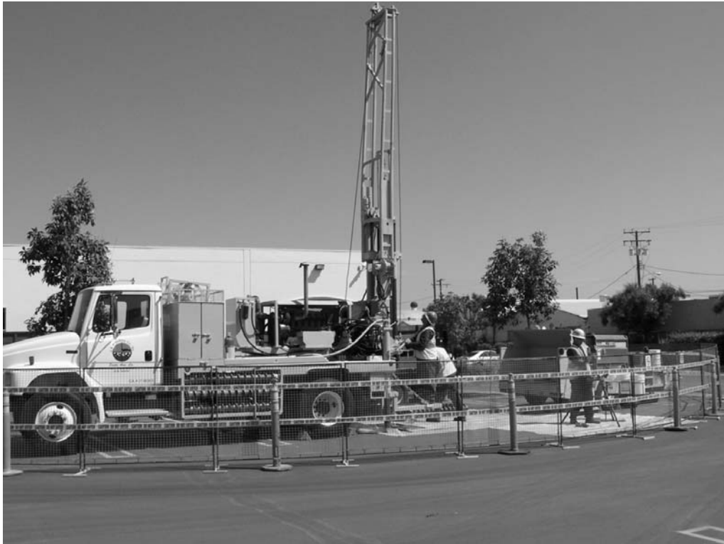
Slika 3.15 Bušači stroj na kamionu
