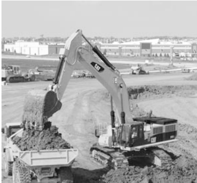
Slika 10.6 Utovar iskopanog tla u kamion jaružalom (bagerom)
