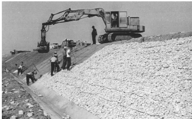
Slika 14.22 Zaštita pokosa gabionima punjenim kamenom (Miščević), zamjenjuju roliranje kamenom
