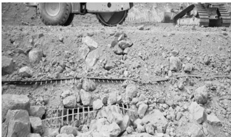
Slika 11.88 Armirani nasip bez lica
