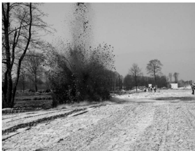
Slika 11.30 Učinak miniranja na površini ( http://www.polbud-pomorze.pl )
