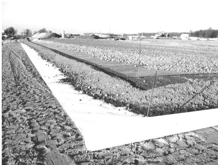
Slika 11.15 Ojačanje posteljice i nasipa geomrežom i geotekstilom
