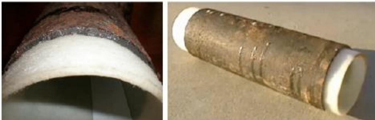
Slika 31. Primjer cijevi obnovljene CIPP metodom [11]
