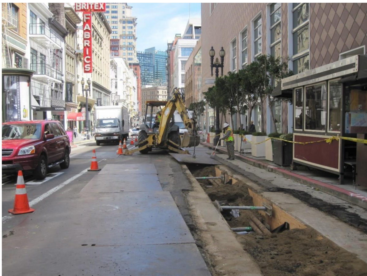
Slika 17. Posljedice korištenja tradicionalne metode u urbanoj sredini [10]
