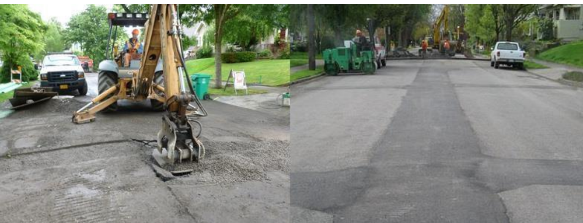
Slika 16. Zbijanje nasutog materijala i privremeni asfaltni sloj [10]
