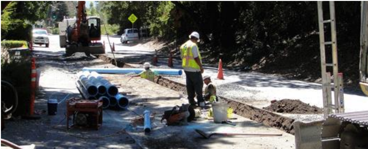
Slika 14. Oprema i materijali skladišteni na gradilištu [10]
