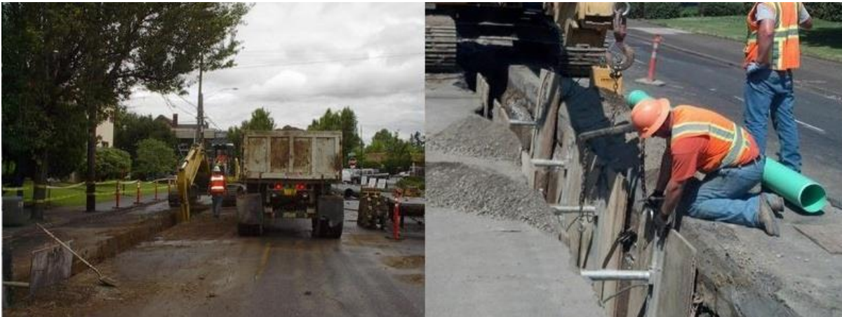
Slika 15. Iskop rova i postavljanje cijevi [10]
