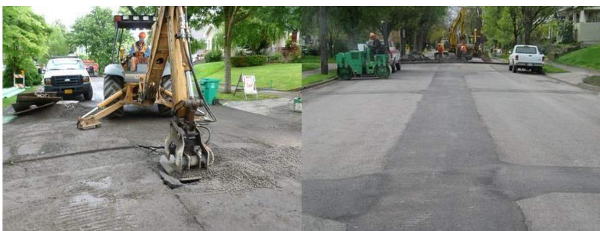
Slika 16. Zbijanje nasutog materijala i privremeni asfaltni sloj [10]
