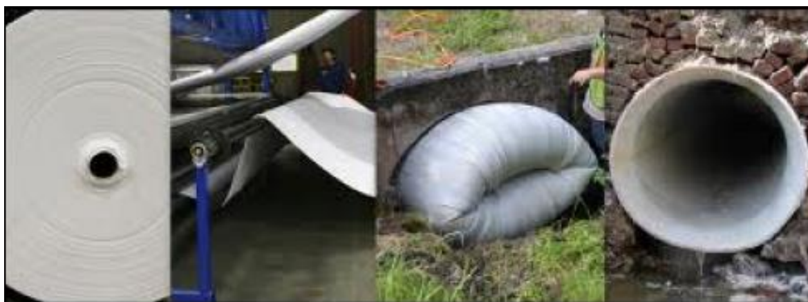
Slika 33. Poliesterska ispletena cijev [11]
