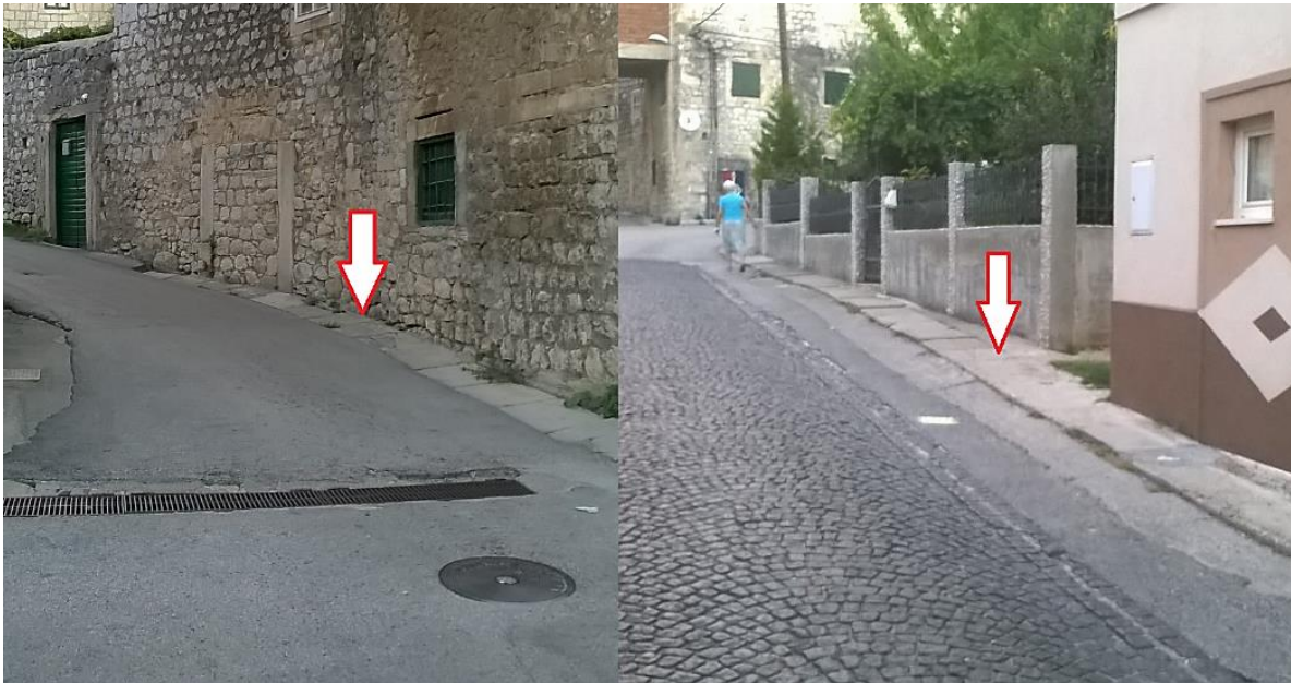
Slika 8. Stari popločani oborinski kanali
