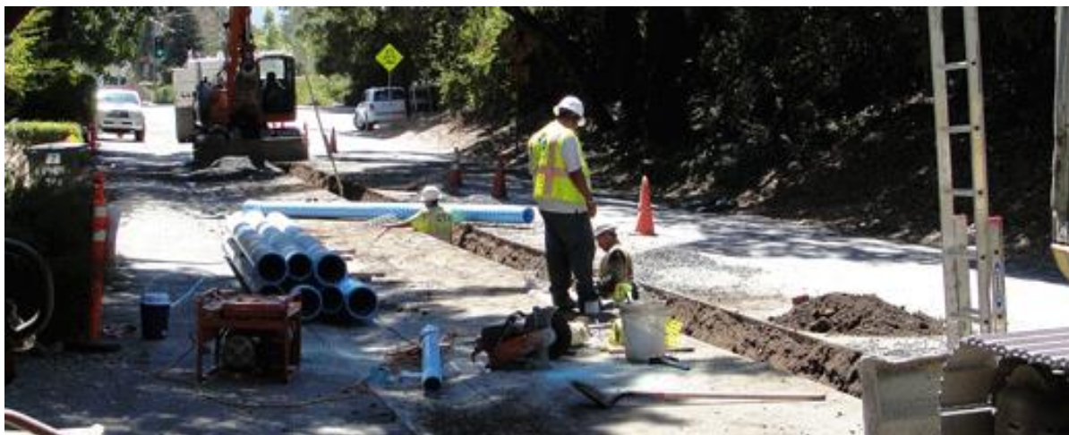
Slika 14. Oprema i materijali skladišteni na gradilištu [10]
