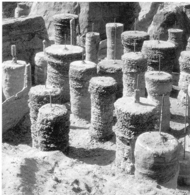
Slika 8.23 Probno polje mlazno injektiranih stupnjaka s armaturnom šipkom u osi
