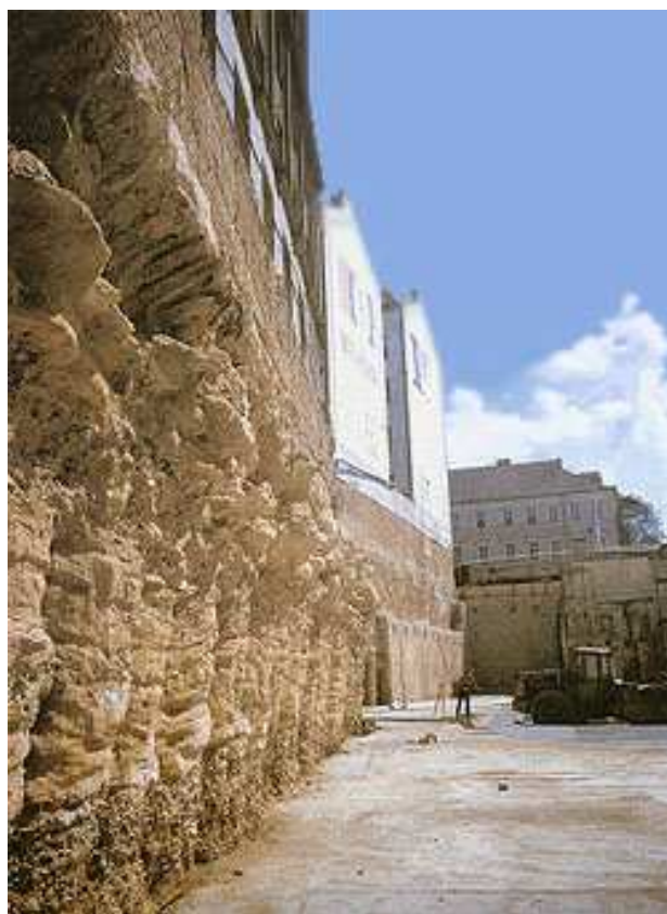
Slika 8.10 a Tehnika zaštite iskopa prikazana na slici 8.10 u izvedenom stanju
