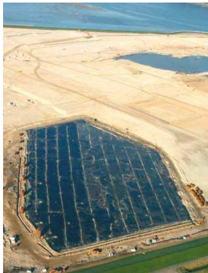
Slika 9.63 Polje podvrgnuto vakuum konsolidaciji
