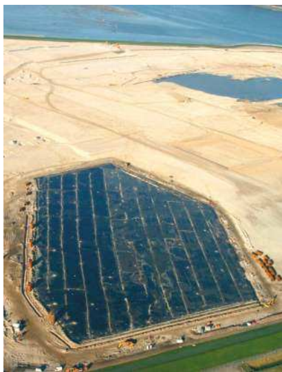
Slika 9.63 Polje podvrgnuto vakuum konsolidaciji
