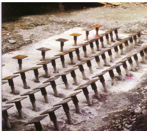
Slika 8.14 Glave unakrsnih pilota izvedenih od čeličnih cijevi
