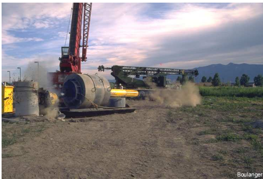
Slika 5.45 Pokus vodoravnog opterećenja pilota velikog kružnog poprečnog presjeka (Boulanger, 1997.) Vide se sanjke i odbojnik koji zaustavlja teret.
