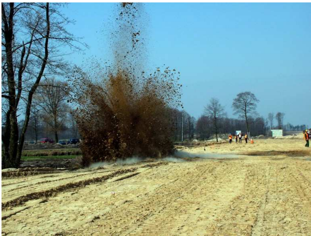
Slika 9.43 Učinak miniranja na površini (WEB 16)
