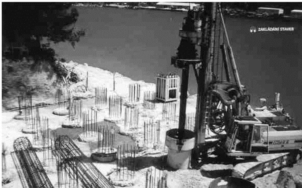
Slika 5.76 Piloti na radilištu temelja mosta na Rijeci Dubrovačkoj (Masopust, 2006.)
