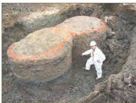
Slika 9.19 Otkopana tijela stabiliziranog tla
