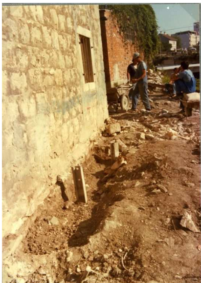
Slika 8.2 Željezničke šine kao dio mikropilota na površini terena (snimio: M. Čagalj)
