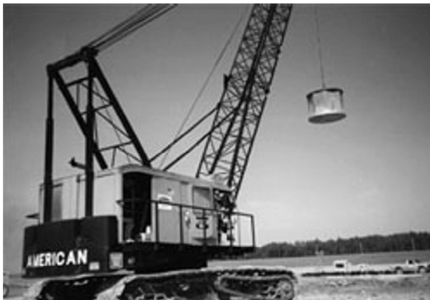
Slika 9.20 Oprema za dinamičko zbijanje tla
