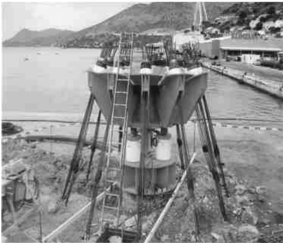
Slika 5.17 Opterećenje za pokus nosivosti pilota na pritisak, luka Gruž, Dubrovnik
