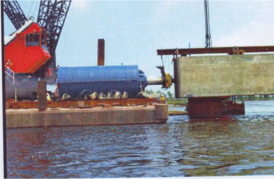
Slika 5.46 Ispitivanje grupe pilota povezanih naglavnicom na koju djeluje opterećenje
