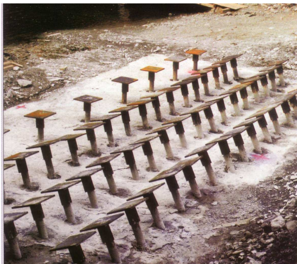
Slika 8.14 Glave unakrsnih pilota izvedenih od čeličnih cijevi
