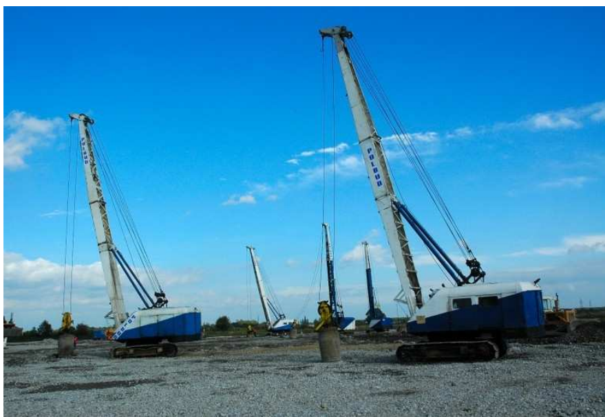
Slika 9.26 Polje s nizom strojeva za dinamičku stabilizaciju s dodatnim nasipanjem
