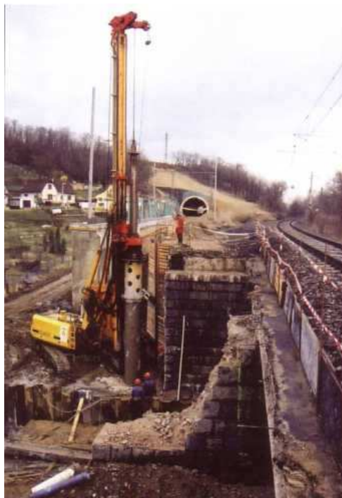
Slika 5.73 Iskop bušotine za pilot pod zaštitom cijevi (zaštitne kolone)
