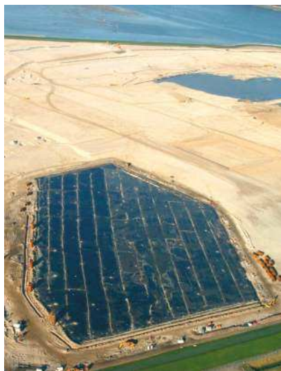
Slika 9.63 Polje podvrgnuto vakuum konsolidaciji
