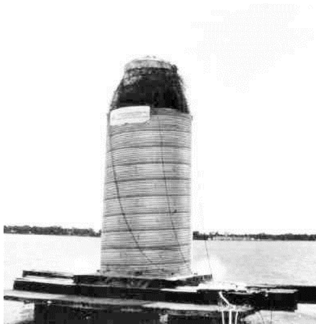
Slika 5.44 Uređaj sa šljunčanim punjenjem na pilotu u dubokoj vodi
