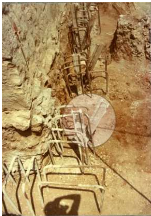
Slika 8.3 „Kuća od kamena“, željezničke šine i armatura kontrafora (snimio:M. Čagalj)
