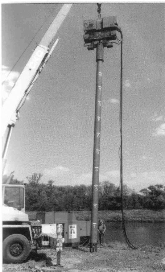
Slika 5.62 Pilot spreman za zabijanje pomoću vibro-glave (Zakladani staveb, 2003.).
