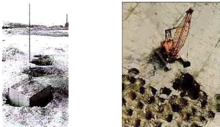
Slika 9.21 Učinak pada utega pri dinamičkoj stabilizaciji (WEB 6)
