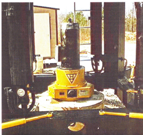
Slika 5.38 Klip na glavi pilota, između klipa i pilota je ćelija za mjerenje pritiska
