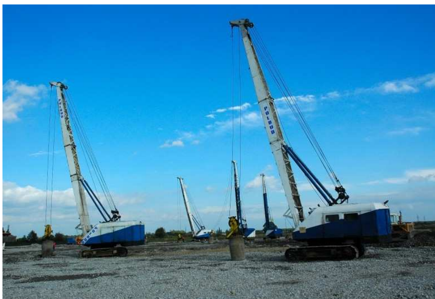
Slika 9.26 Polje s nizom strojeva za dinamičku stabilizaciju s dodatnim nasipanjem
