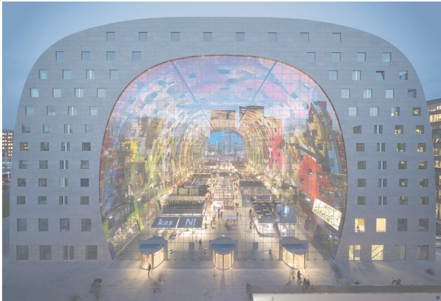
Markthal, Rotterdam, Nizozemska, MVRDV
