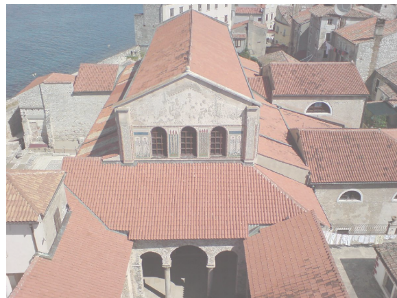
Slika 25: Eufrazijeva bazilika, Poreč, 6.st. - ranokršćanska arhitektura Izvor: http://www.photo-galleries.org/eufrazijeva-bazilika.htm
