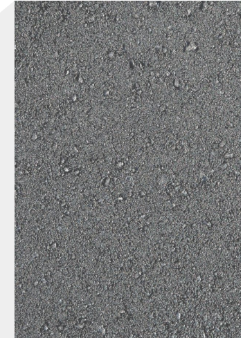
Asfalt, rampa podzemne garaže
