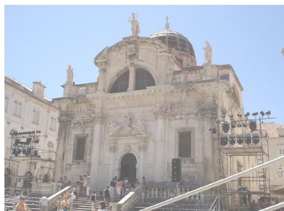
Slika 43: Crkva Svetog Vlahu, Dubrovnik, arhitekt Marino Gropelli, 1706.-1715.g. - barok Izvor: https://hr.wikipedia.org/wiki/Crkva_sv._Vlaha_u_Dubrovniku
