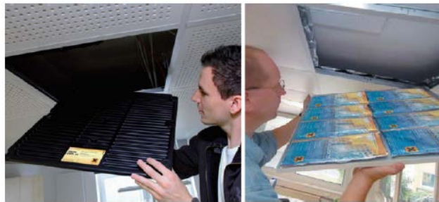
Slika 28. Način ugradbe PCM ploča, [14].
