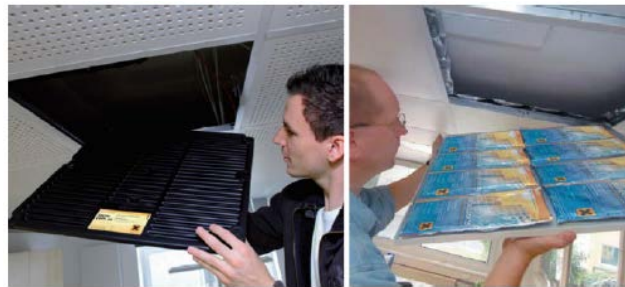
Slika 28. Način ugradbe PCM ploča, [14].
