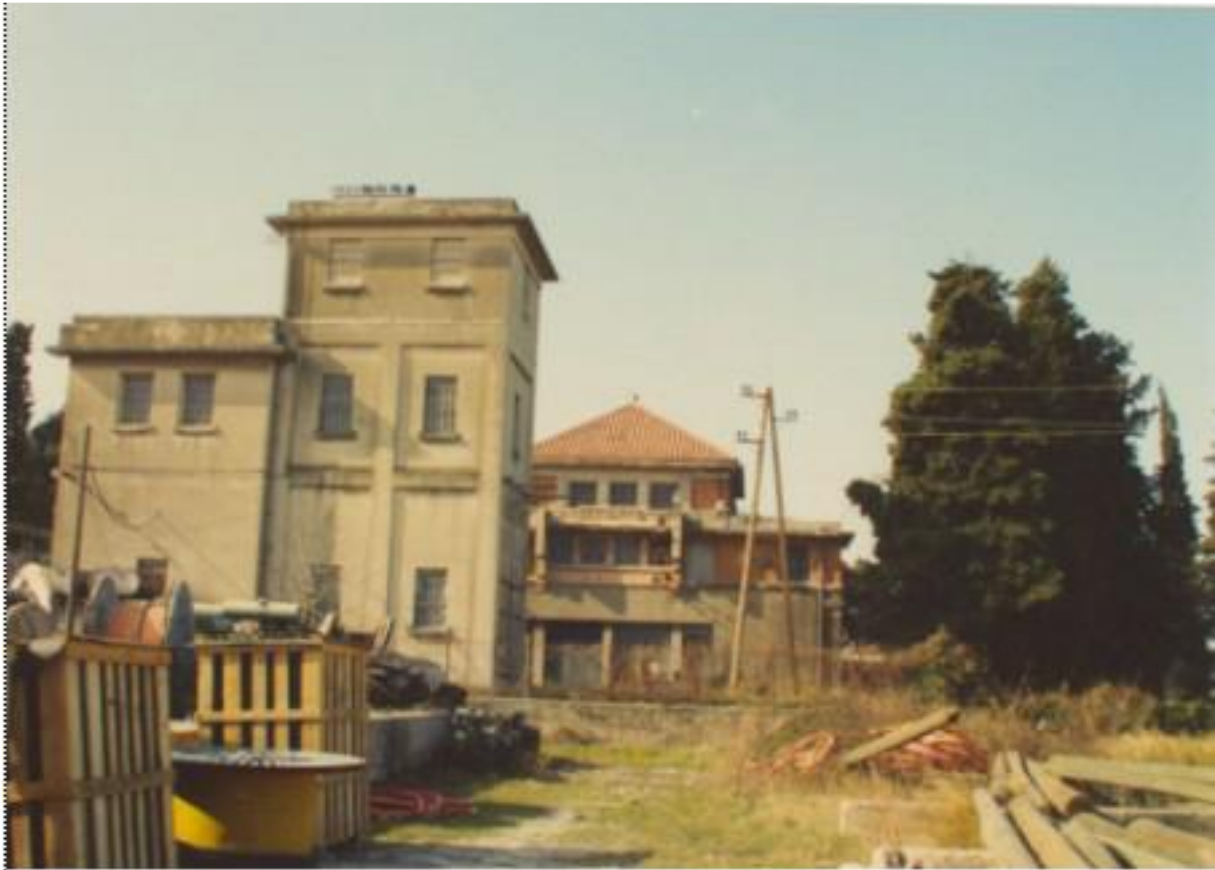
Slika 4. Pogled na trafostanicu s istoka.
