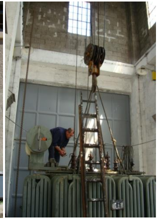
Slika 14: Dizalica, druga Kodlova trafostanica
