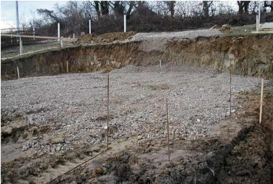
Slika 2.6. Stanje temeljnog tla nakon zemljanih radova [3]
