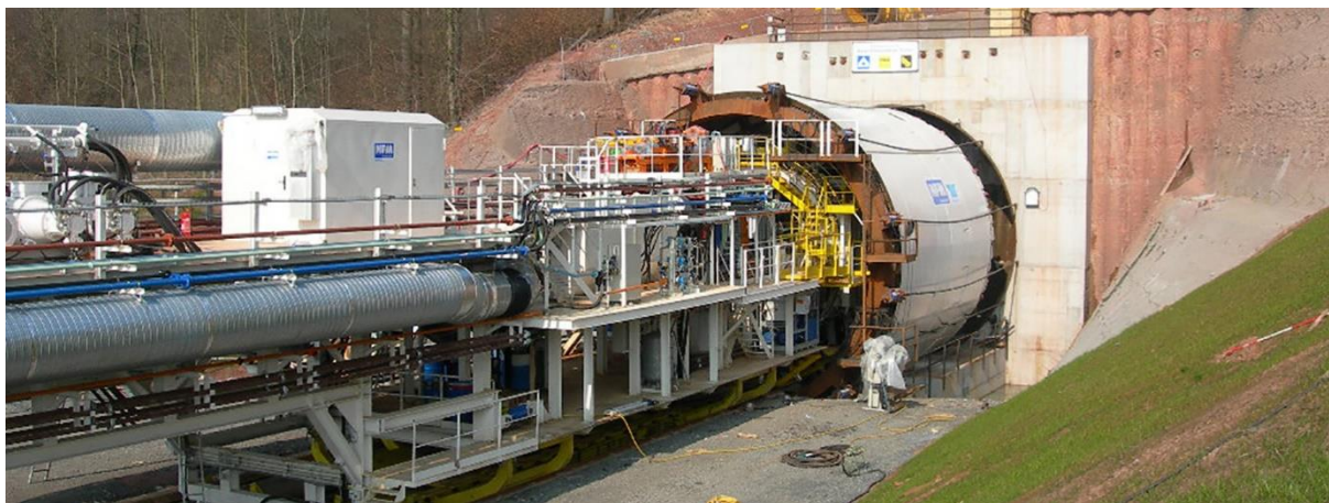
Slika 2. Prikaz probijanja tunela TBM-om [ ]
