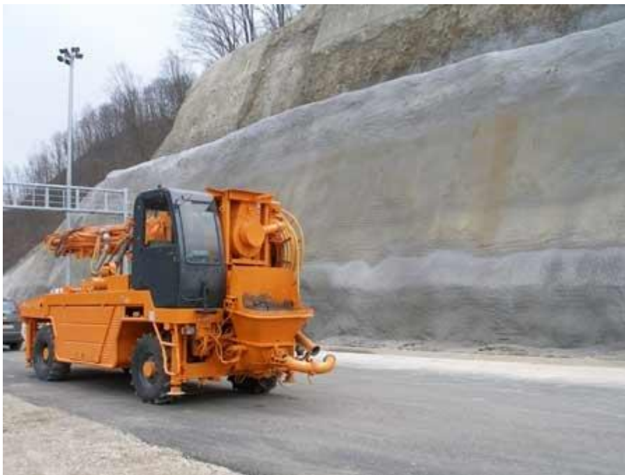
Slika 11. Stroj CIFA SPRITZ SYSTEM CSS-2 za torkretiranje
