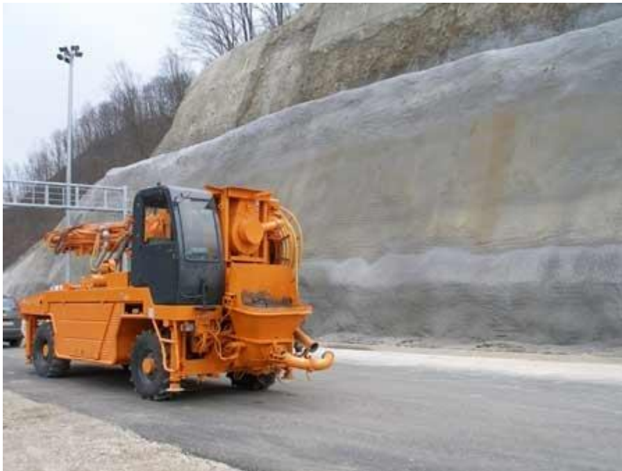
Slika 11. Stroj CIFA SPRITZ SYSTEM CSS-2 za torkretiranje
