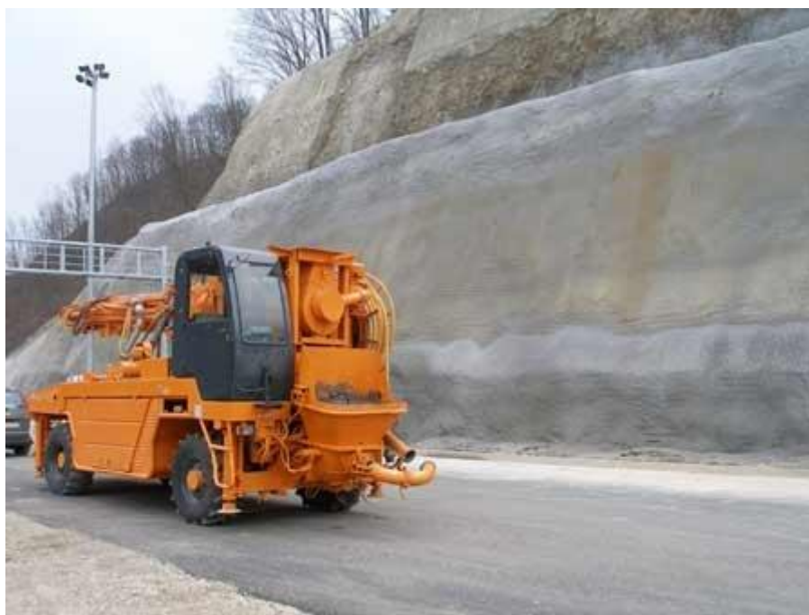
Slika 11. Stroj CIFA SPRITZ SYSTEM CSS-2 za torkretiranje
