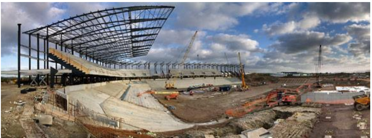
Slika 10.1: Prikaz slične konstrukcije betona i čelika u fazi izvedbe
