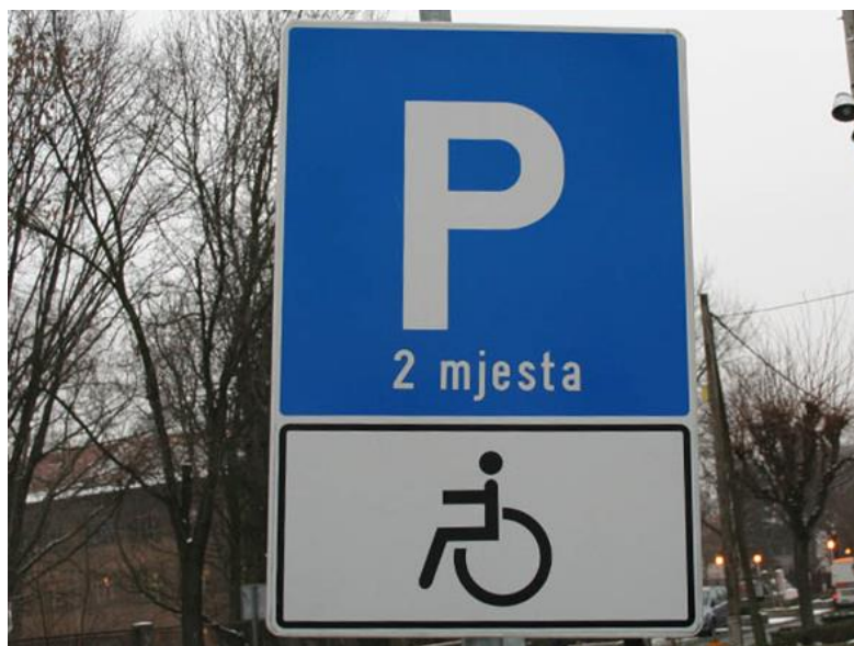
Slika 16 Vertikalna signalizacija parkirališnog mjesta za osobe s invaliditetom [23]
