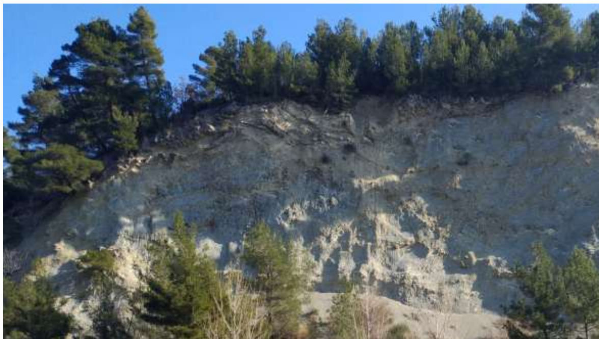
Slika 7. Karakteristike stijenske mase na istočnom zasjeku; heterogene flišne naslage sa slojevima čvrstih vapnenačkih pješčenjaka pri vrhu padine
