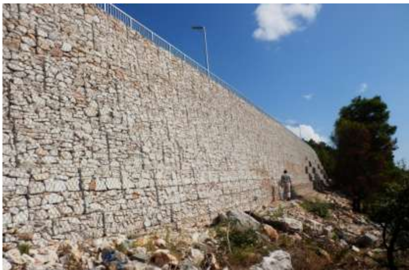
Slika 37. Primjer slaganja gabioske konstrukcije [23]
