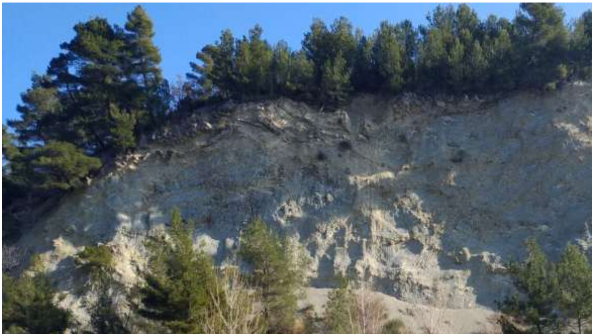
Slika 7. Karakteristike stijenske mase na istočnom zasjeku; heterogene flišne naslage sa slojevima čvrstih vapnenačkih pješčenjaka pri vrhu padine
