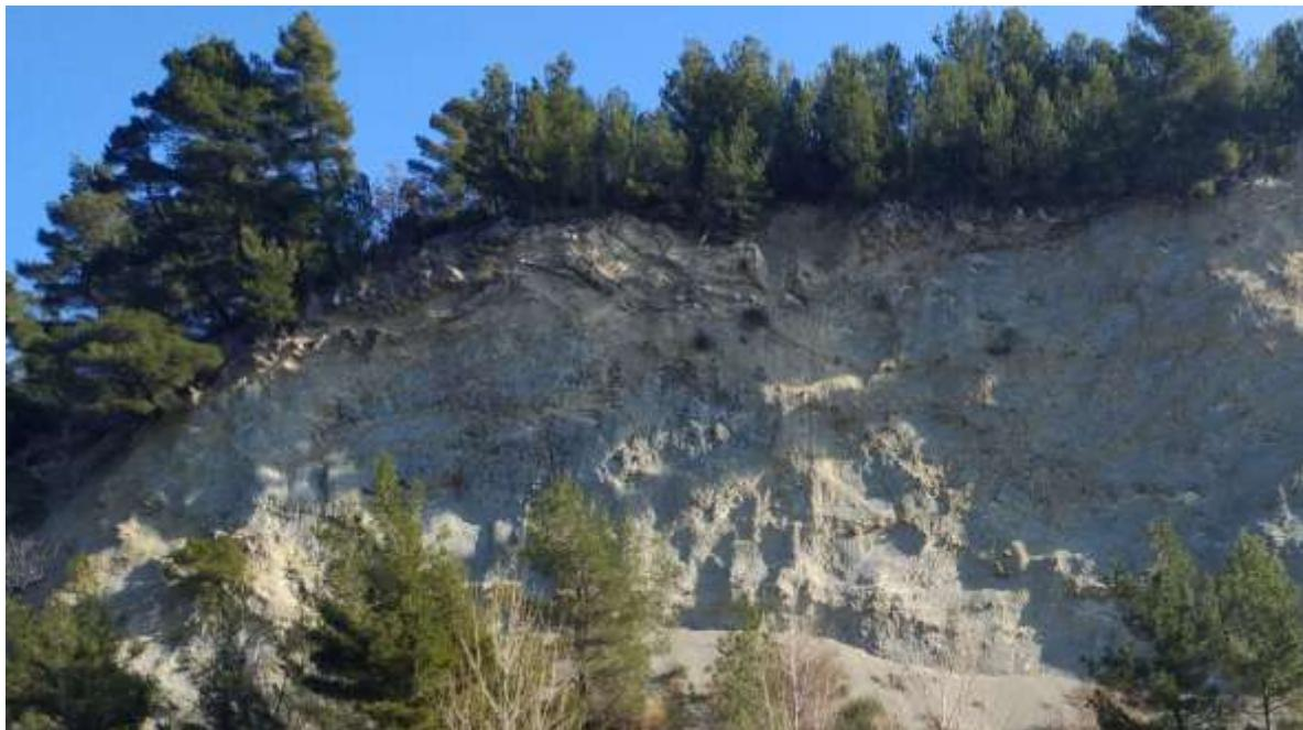
Slika 7. Karakteristike stijenske mase na istočnom zasjeku; heterogene flišne naslage sa slojevima čvrstih vapnenačkih pješčenjaka pri vrhu padine
