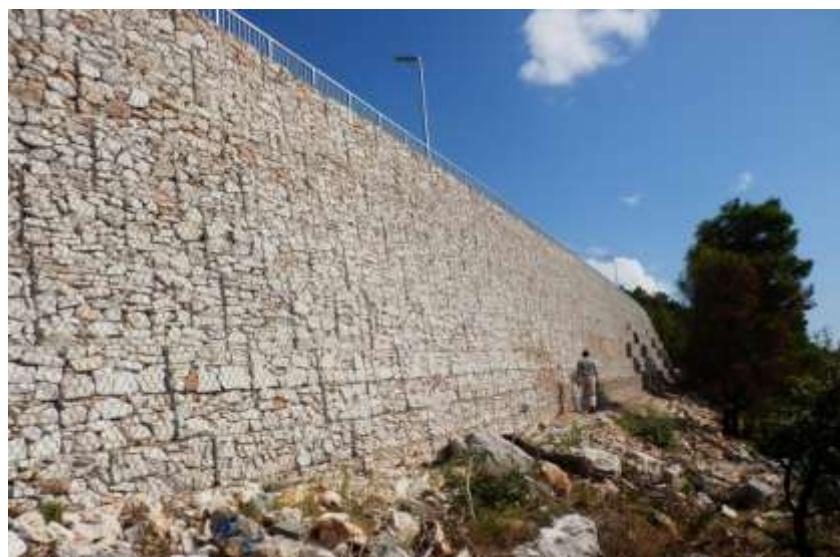
Slika 37. Primjer slaganja gabioske konstrukcije [23]
