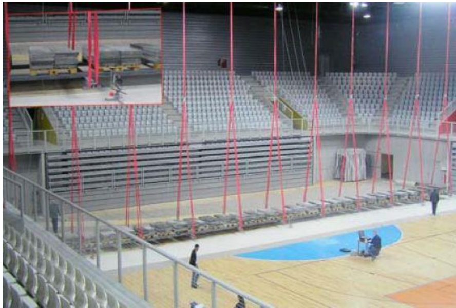
Fotografija 1.1: Statičko ispitivanje rešetkaste konstrukcije sportske dvorane
