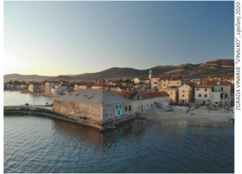
ZGRADA VINARIJE "VINALKO", siječanj, 2020.
