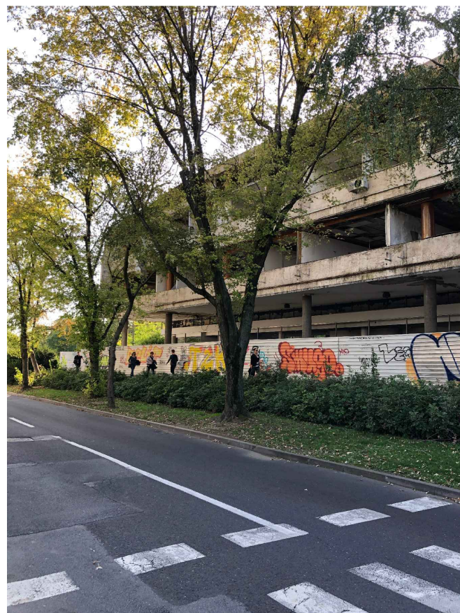
▲ ZATEČENO STANJE ISTOČNE FASADE
