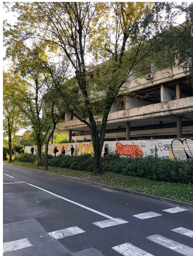
▲ ZATEČENO STANJE ISTOČNE FASADE
