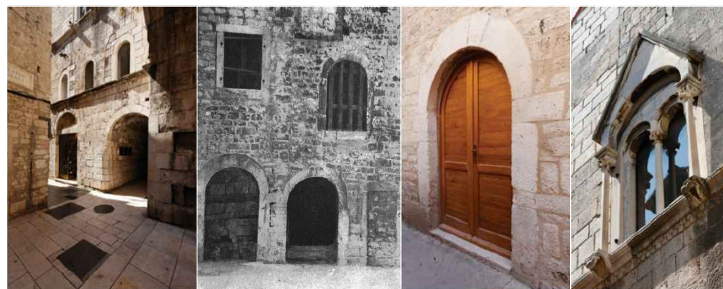
ROMANIČKO PROČELJE ZGRADE U DIOKLECIJANOVOJ ULICI
