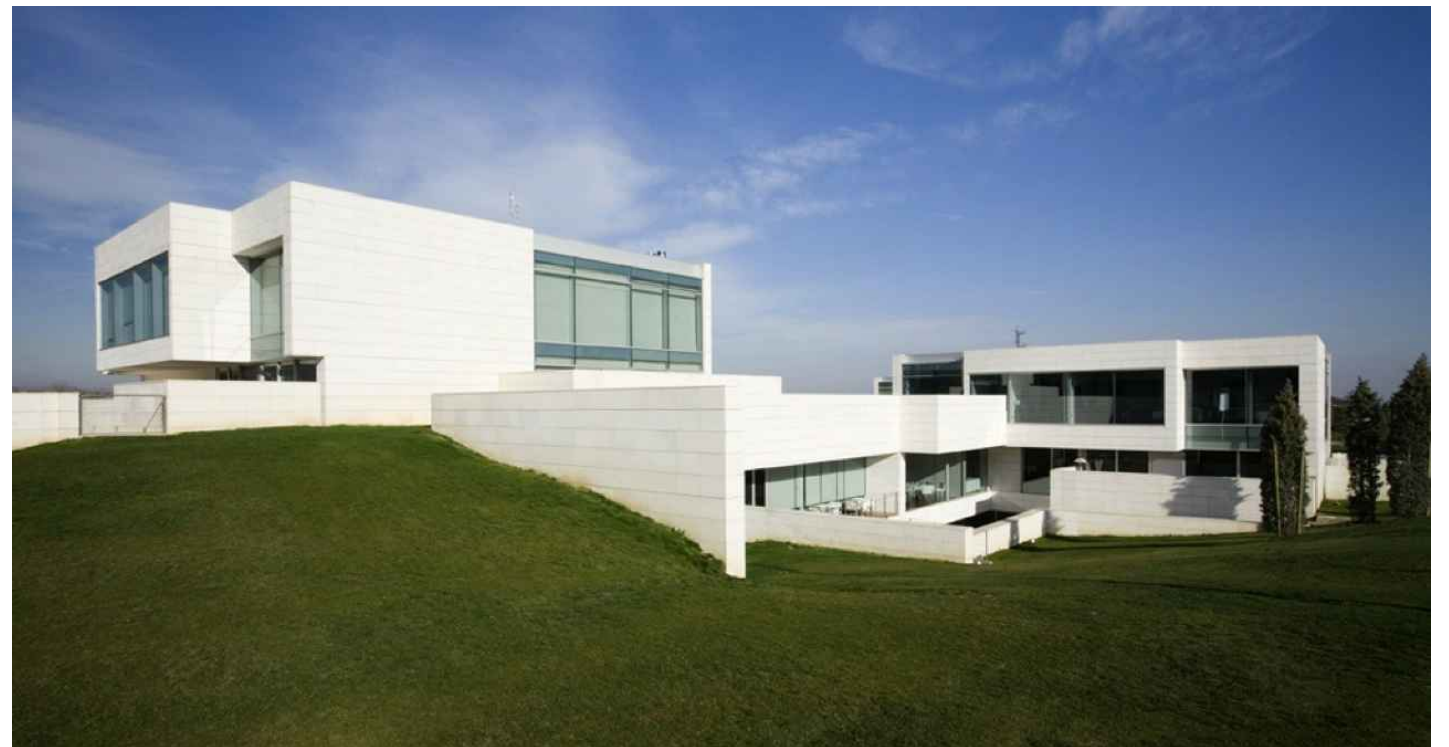
Finca Prats Hotel Golf & Spa / Pàmpol Arquitecte SLP
