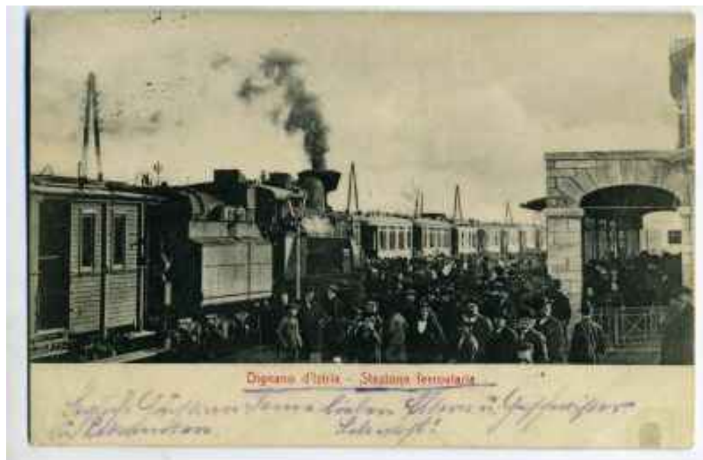
stanica u Vodnjanu PPMI-R-2288, POLA - Stazione, 1914. - 1915.
