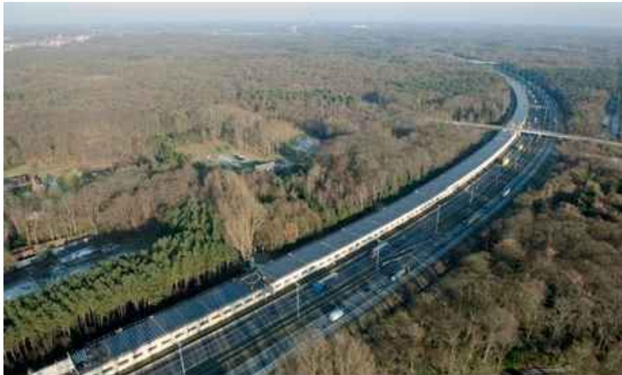
željeznički tunel u Belgiji, na relaciji Pariz - Amsterdam prekriven je sa 16,000 solarnih panela koji pokreću vlak i opskrbljuju zajednicu
