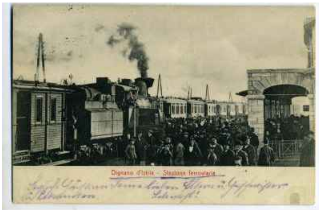
stanica u Vodnjanu PPMI-R-2288, POLA - Stazione, 1914. - 1915.
