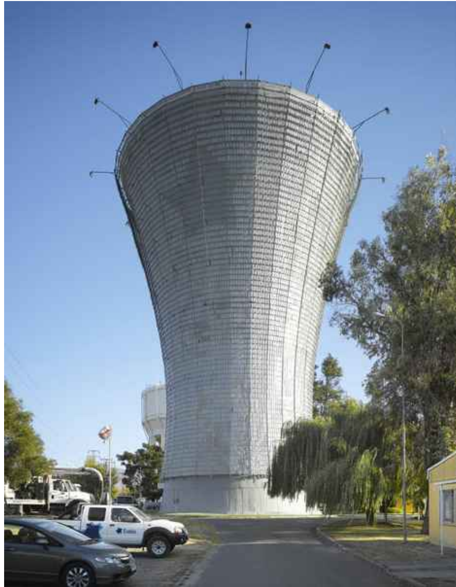
vodotoranj, Mathias Klotz, Rancagua, Čile
