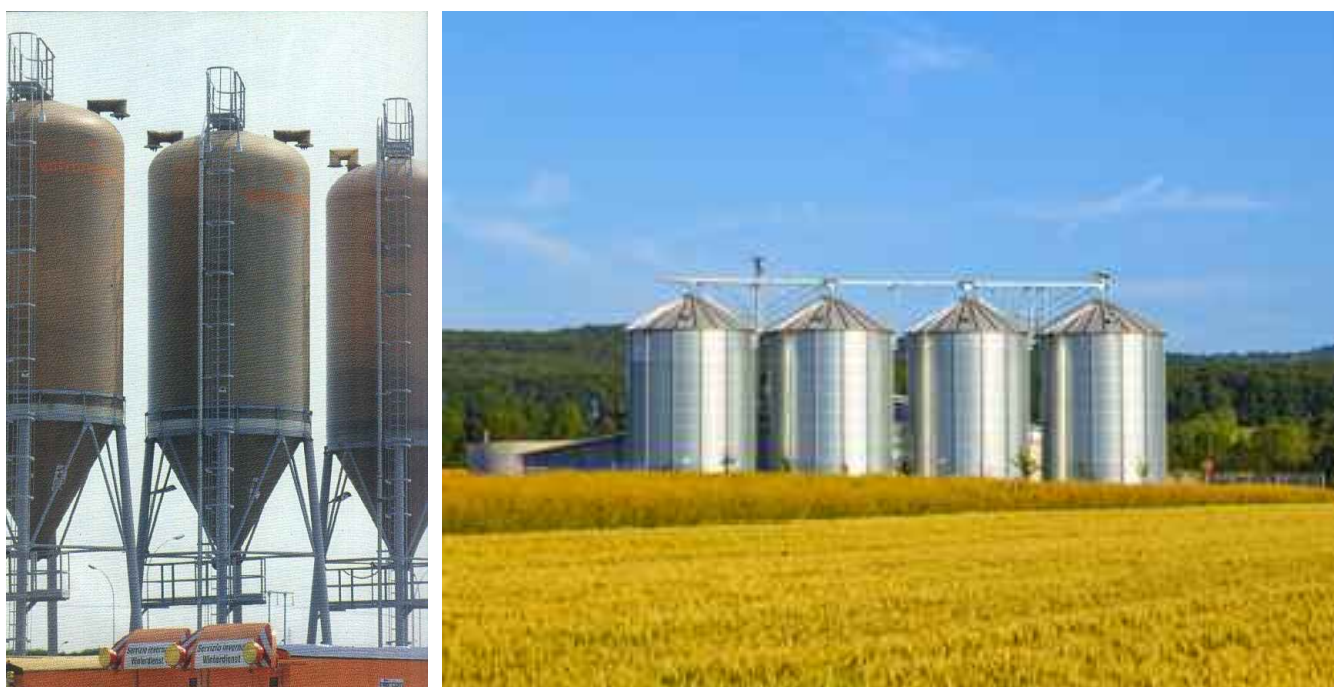
silosi- vertikale za čuvanje i proizvodnju hrane zauzimaju bitnu funkciju u prirodi; postaju zanimljivi atraktori u prostoru
