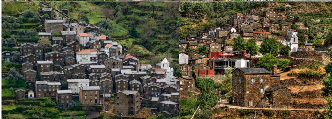
sl. 47. i sl. 48., Piodao, Portugal, izgradnja na strmom terenu
