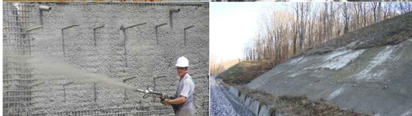
sl. 21., sl. 22. Zaštita pokosa torkretiranjem (mlazni beton)
