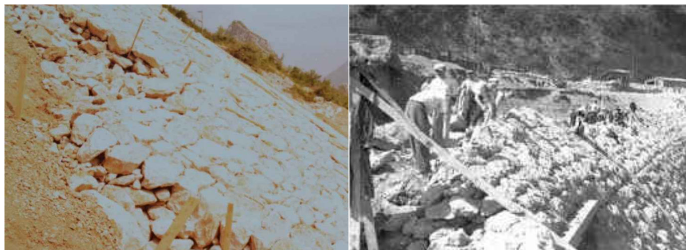
sl.19., sl.20. Izvedba slagane kamene obloge
