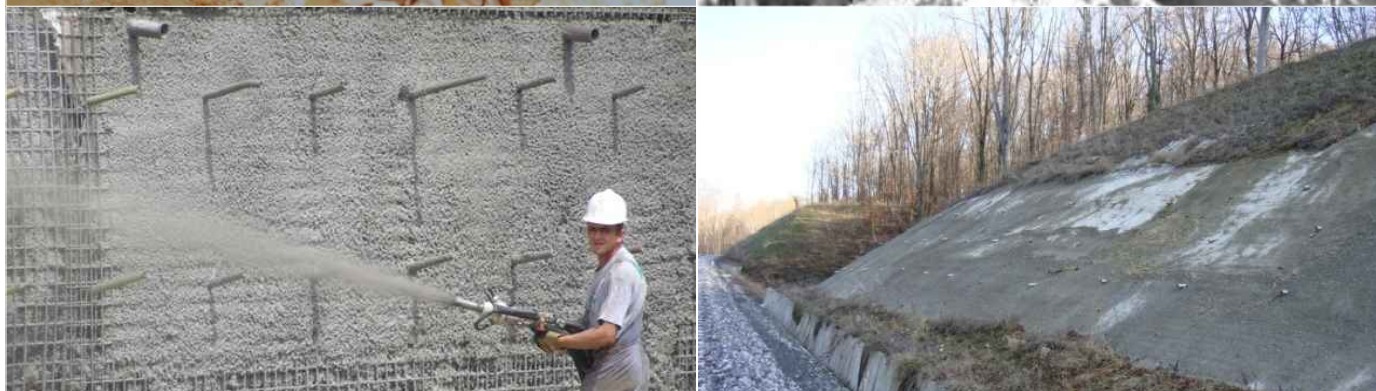
sl. 21., sl. 22. Zaštita pokosa torkretiranjem (mlazni beton)
