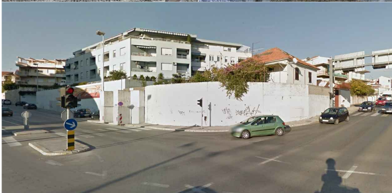
sl. 23., potporni zid na Visokoj, Split
