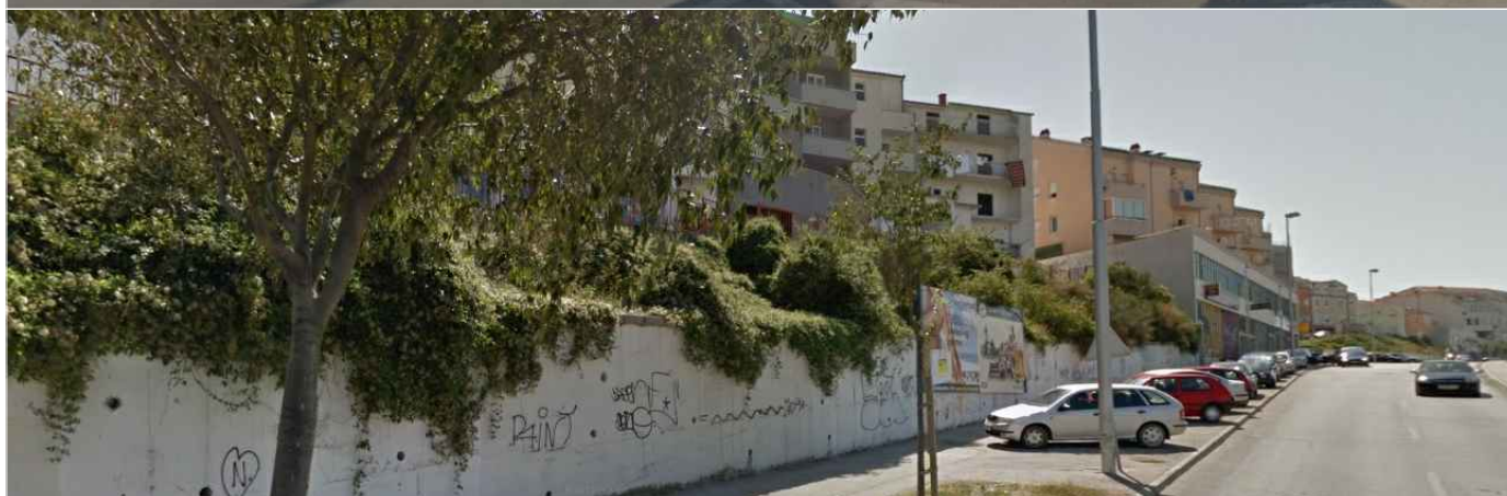
sl. 24., potporni zid na Visokoj, Split
