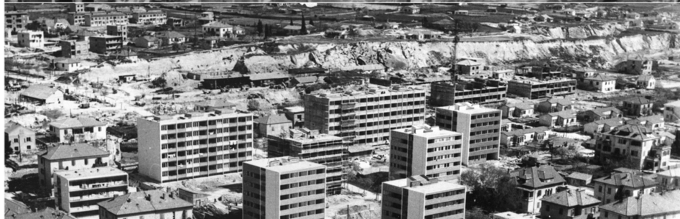
sl. 31. potez tupinoloma u pozadini tipske višestambene izgradnje koncentričnog naselja uz ulicu XX. dalmatinske divizije
