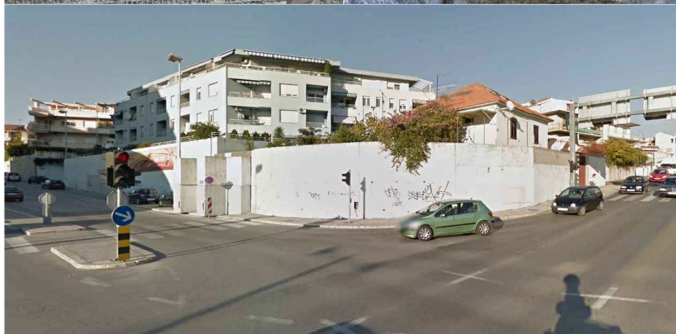
sl. 23., potporni zid na Visokoj, Split
