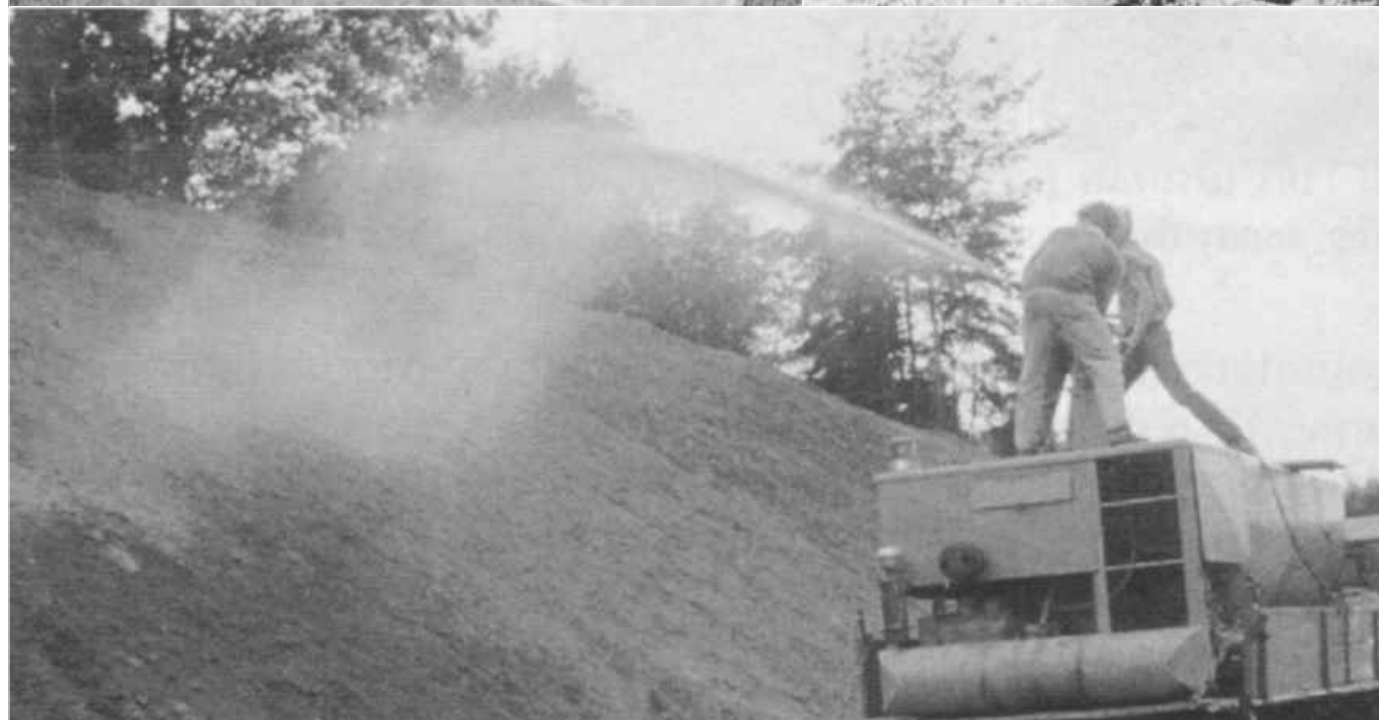
sl.15. Zaštita pokosa travnatim pokrivačem po sistemu hidrosjetve
