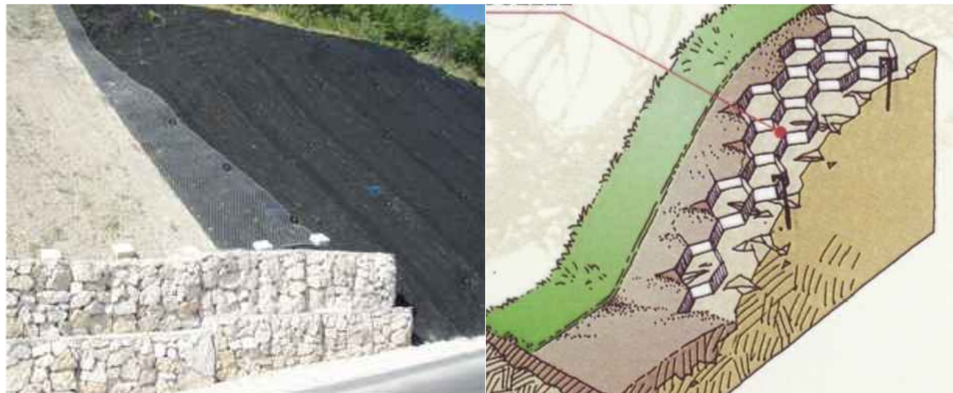
sl.17., lijevo Zaštita pokosa primjenom prekrivača od netkanog geotekstila s uložnim sjemenom trave
