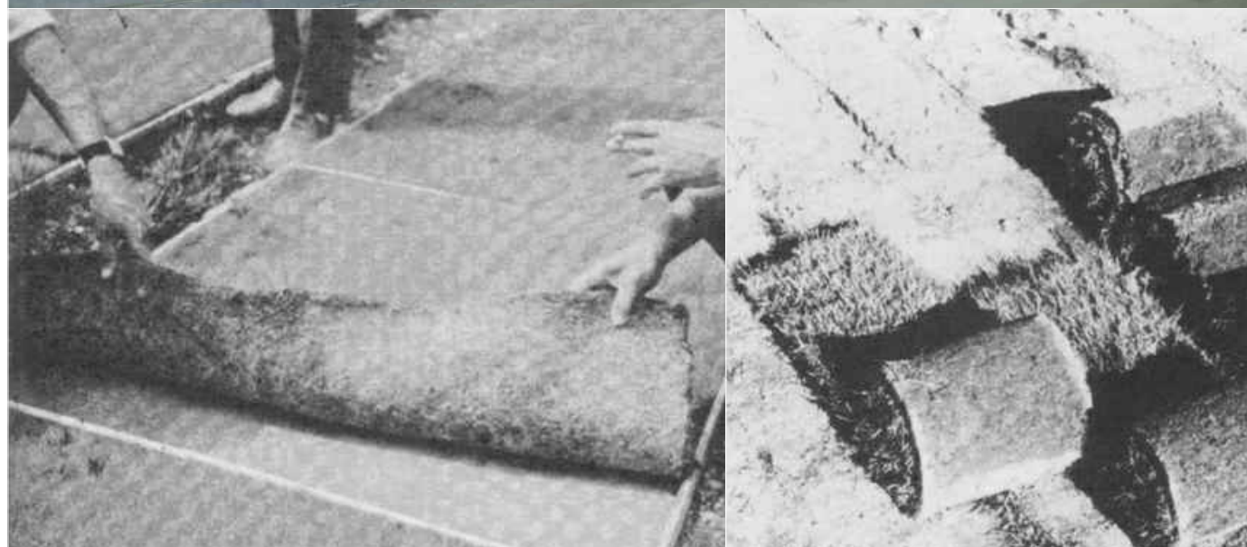
sl.13.,lijevo, Zaštita pokosa primjenom busenja
