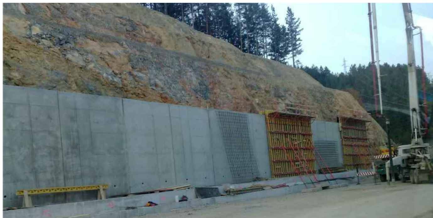
sl.12., Podupiranje pokosa potpornim zidom
