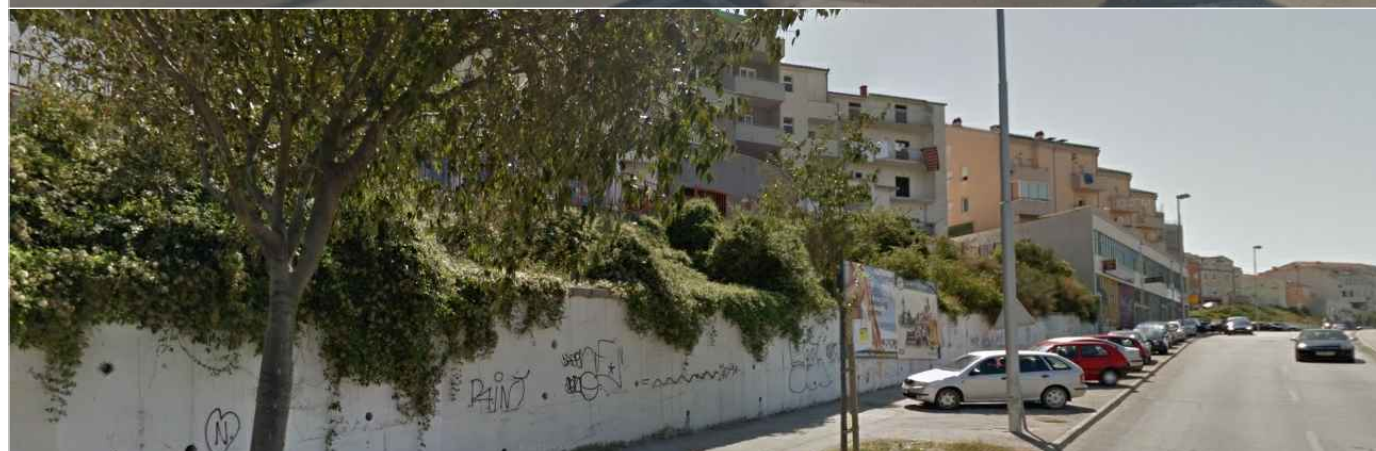
sl. 24., potporni zid na Visokoj, Split
