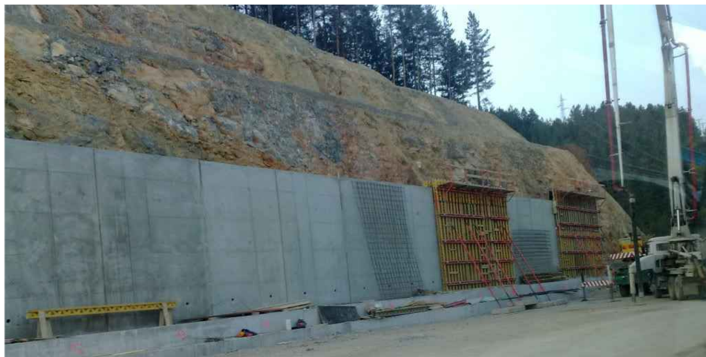
sl.12., Podupiranje pokosa potpornim zidom
