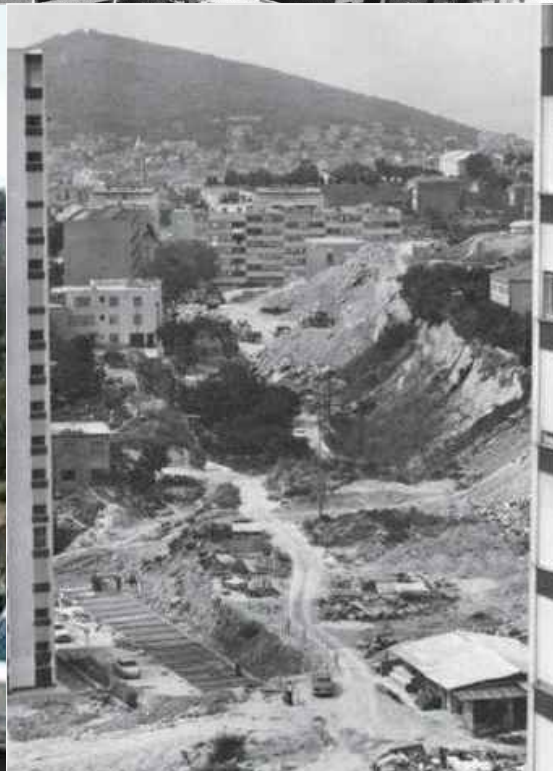
sl. 32., lijevo Višestambena zgrada tipa URBS -1, arhitekta Josipa Vojnovića (1960.) i tragovi nesanimiranog pokosa.
