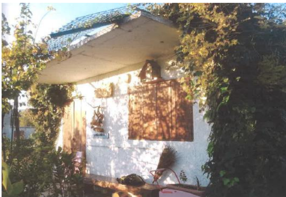
Slika 55. Izvedeno stanje predmetne građevine. (Preuzeto: https://www.google.com/maps/ )
