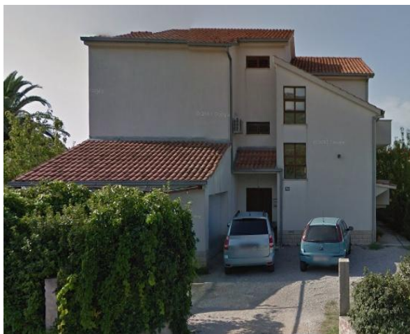
Slika 49. Izvedeno stanje predmetne građevine. (Preuzeto: https://www.google.com/maps/ )
