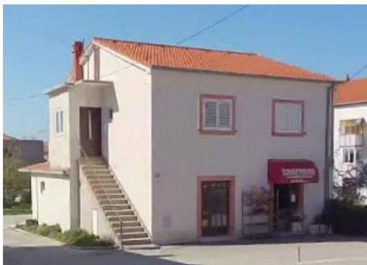
Slika 26. Izvedeno stanje predmetne građevine.
