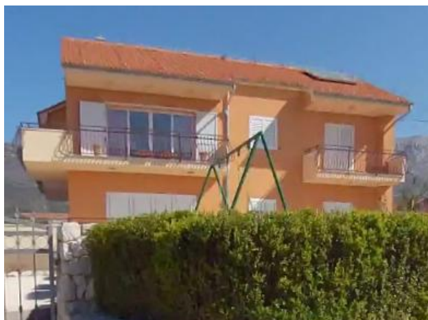
Slika 62. Izvedeno stanje predmetne građevine iz 2019. godine. (Preuzeto: https://www.google.com/maps/ )
