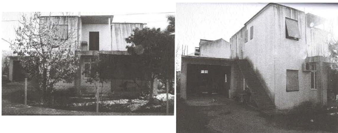
Slika 22. Izvedeno stanje odabrane građevine. (Preuzeto: Fotodokumentacija danim arhitektonskim snimkom)
