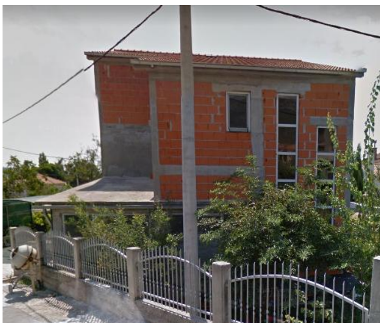
Slika 39. Izvedeno stanje odabrane građevine. (Preuzeto: https://www.google.com/maps/ )
